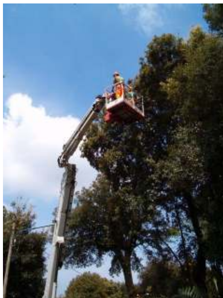
Foto 24 - Operatori su cestello
