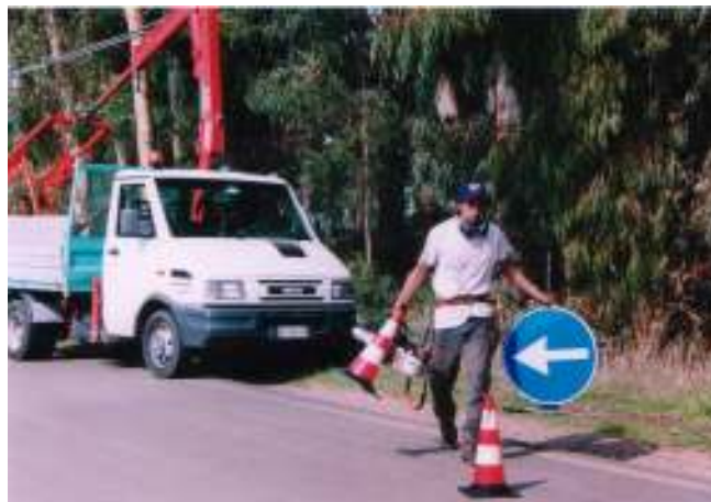
Foto 13 – Allestimento del cantiere
