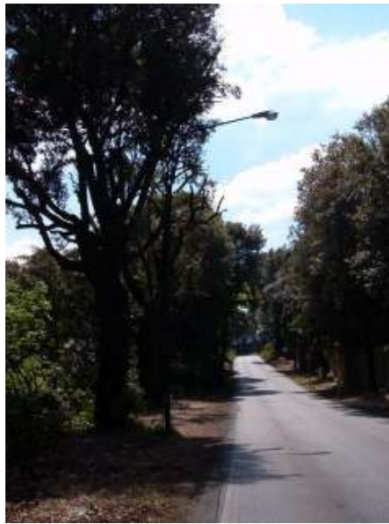
Foto 18 - Viale di leccio dopo l'intervento
