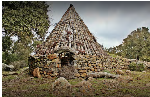
Pinnettas con copertura in legno.
