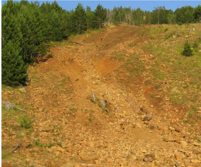
Foto:28. Strada forestale camionabili in cattive condizioni
