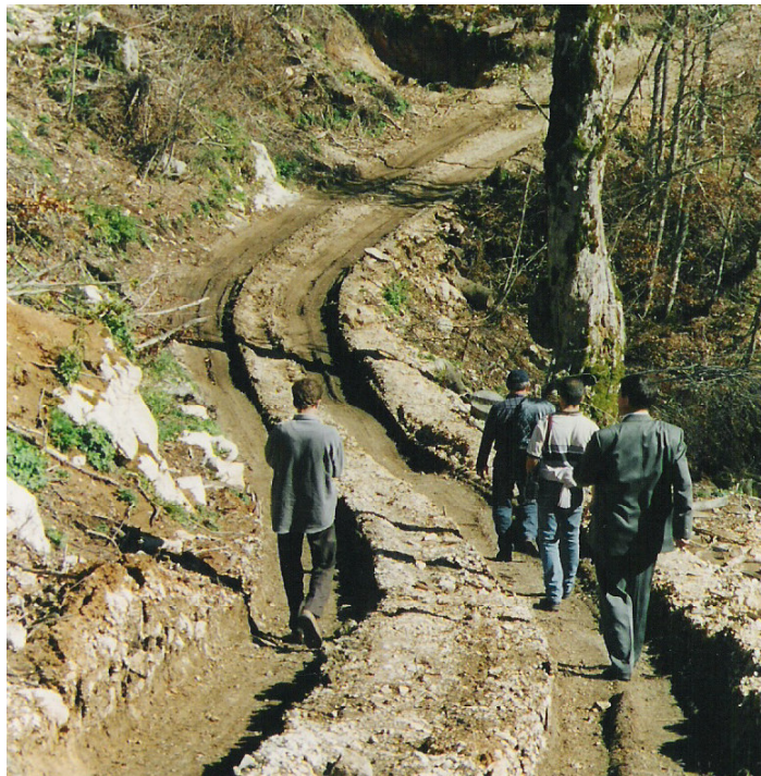
Foto:79. Le cattive condizioni delle strade in Albania.
