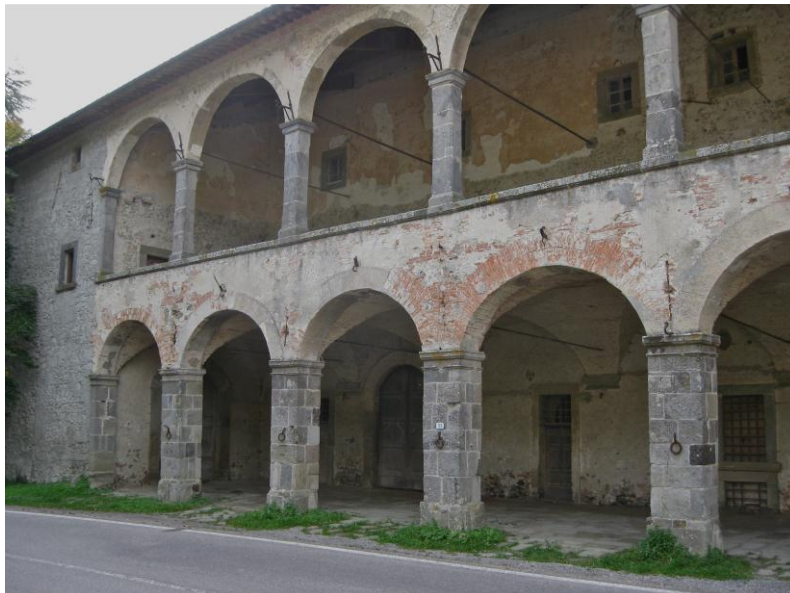
Figura 10. La posta di Radicofani, con i caratteristici due ordini di loggiati. Stalle al pian terreno e camere al primo piano. (Fonte: Google Immagini, 05/04/2012, http://www.panoramio.com/photo/42107945 ).
