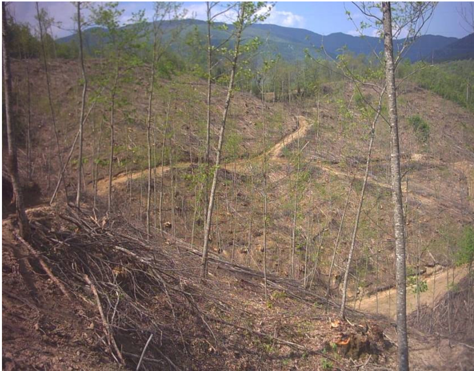
Foto 8: piste principali aperte dalla ditta al momento del taglio, in secondo piano si intravede una pista di raccordo eseguita a ritocchino
