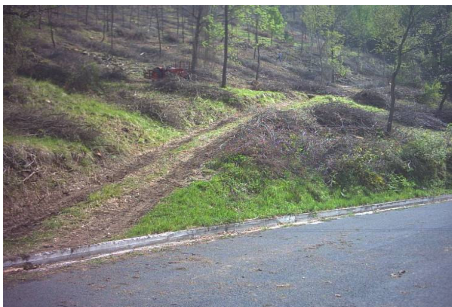
Foto 26: innesto dalla strada ordinaria asfaltata con la pista principale della particella tagliata
