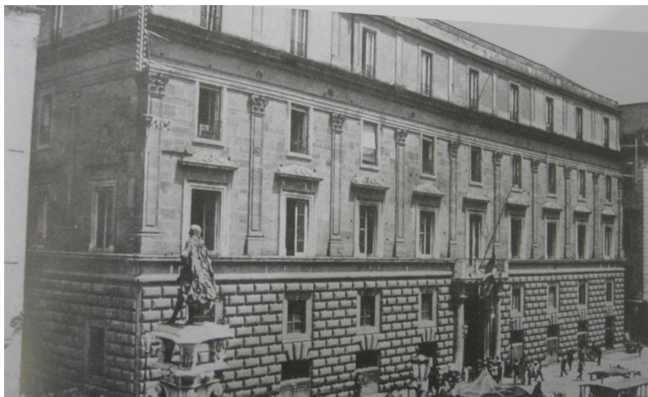
Fig. 90 Palazzo Gravina, facciata, alla fine del 1800
