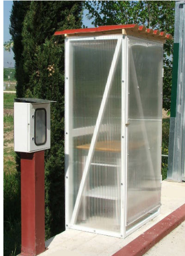
Figura IV.13 - Cabina del misuratore di consumo del carburante.
