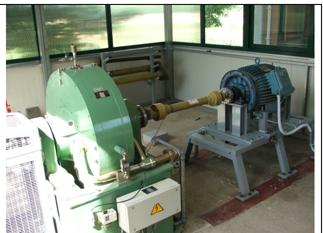
Figura IV.2 - Attrezzature all'interno della sala di prova.
