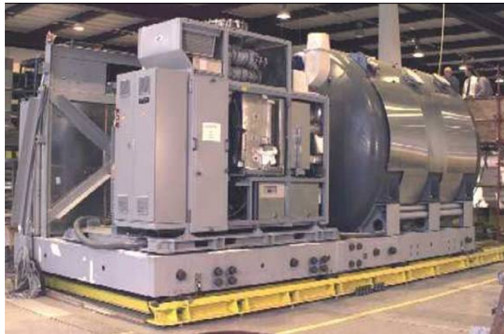
Figura 178: Immagine impianto SOFC accoppiato a turbina gas daella potenza di 300 kW[1]
