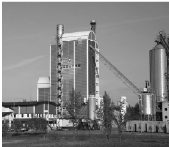
Figura 40 Sito e impianto del Varnamo Biomass Gassification Centre [2].
