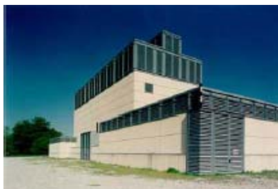
Figura 175: L'impianto PAFC da 1,3 MW installato al polo tecnologico di Milano.[1]
