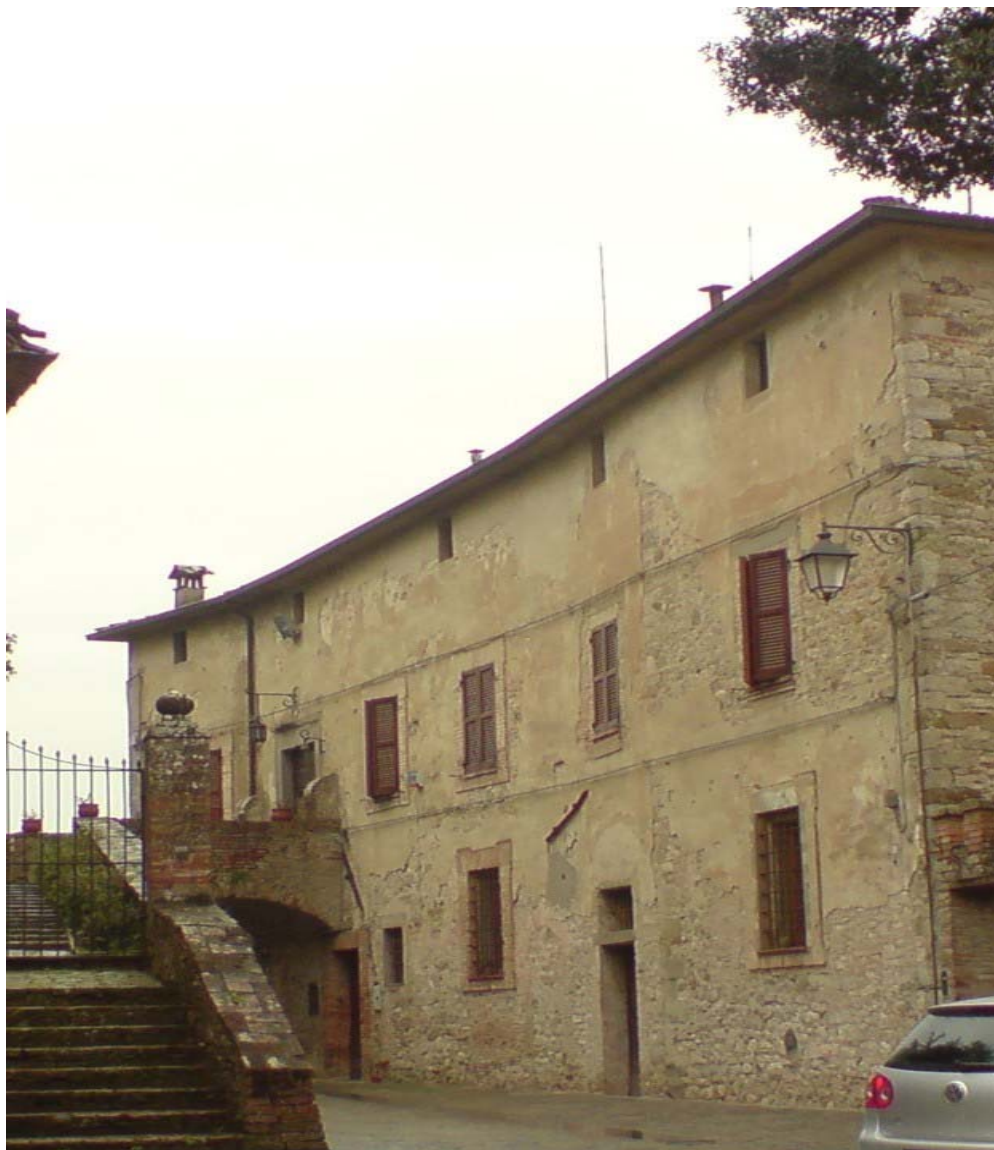
Fig. 6.29 – Fabbricato adibito ad agriturismo in una Aatv
