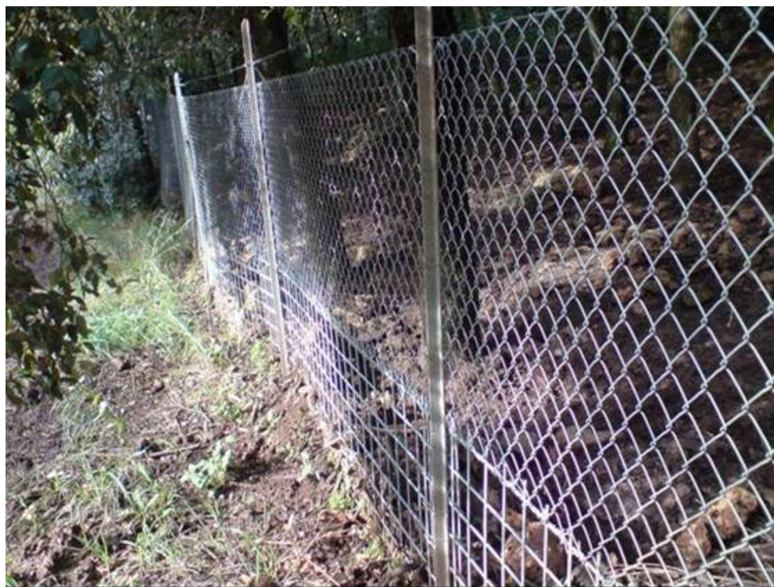
Fig. 6.35 – Recinzione da cinghiali
