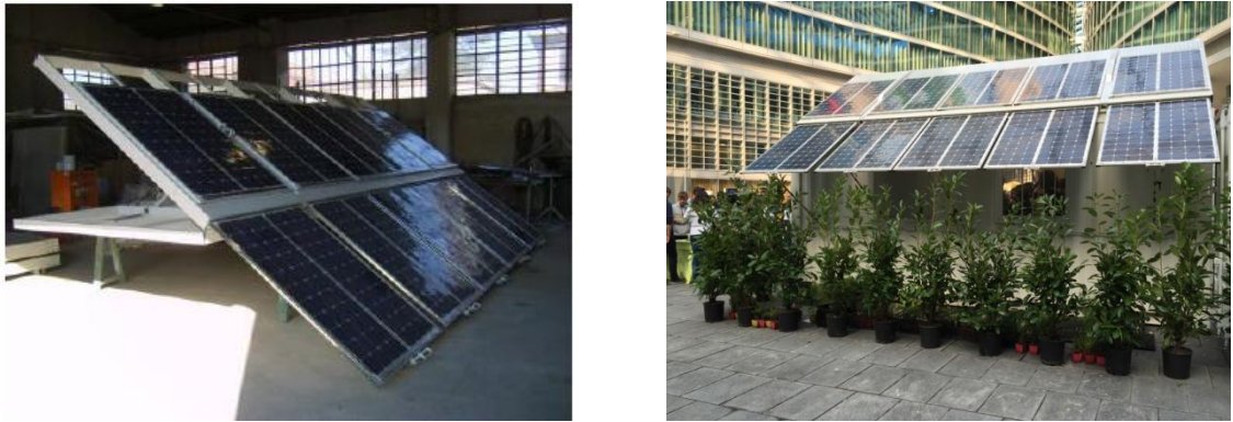
Figura 36. Pannelli fotovoltaici prima e dopo il montaggio sul container
