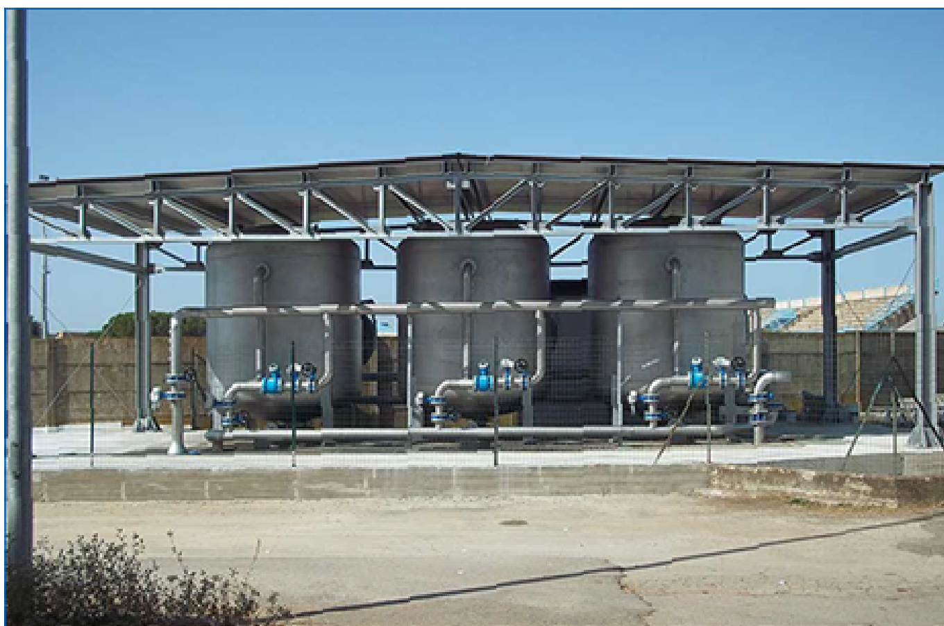
Figura 5.2: Impianto di dearsenificazione a servizio di un acquedotto municipale
