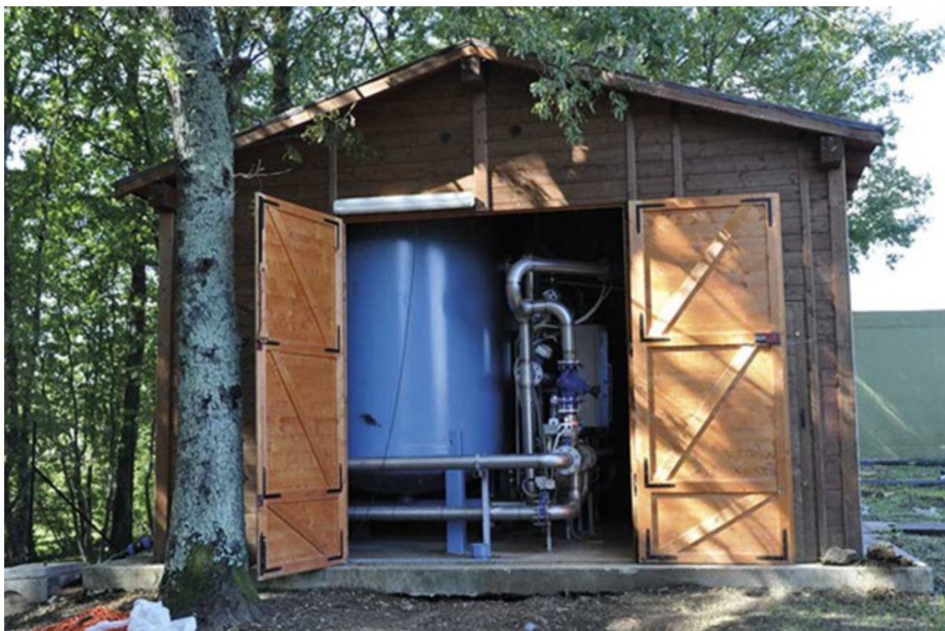
Figura 5.3: Impianto di dearsenificazione a servizio di un acquedotto municipale
