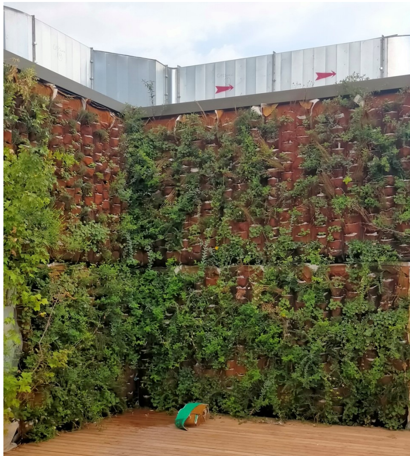
Fig.2 La Parete 12 appena piantumata, e densità di impianto (35/40 piante al m 2 ) che consente di avere già ampi tratti coperti del materassino di radicazione.
