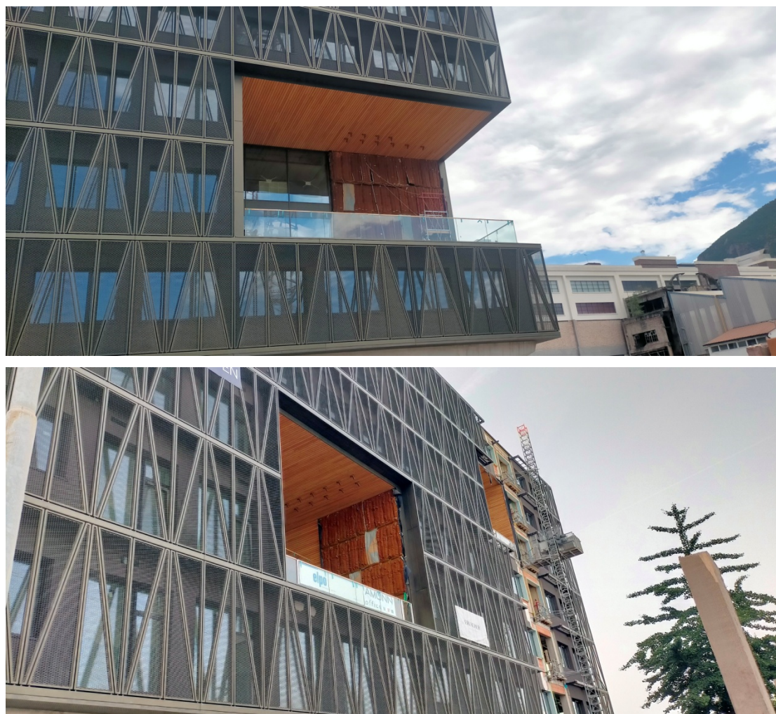
Fig. 1 Visualizzazione della posizione di alcune delle pareti dell'impianto a verde verticale, pareti che hanno richiesto uno studio botanico con specifica attenzione a tutte le direzioni di esposizione e diversi livelli di illuminazione
