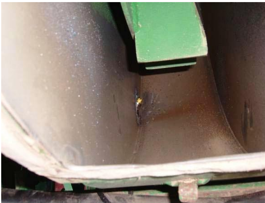
Foto 11. Ugello all'interno del condotto di aspirazione
