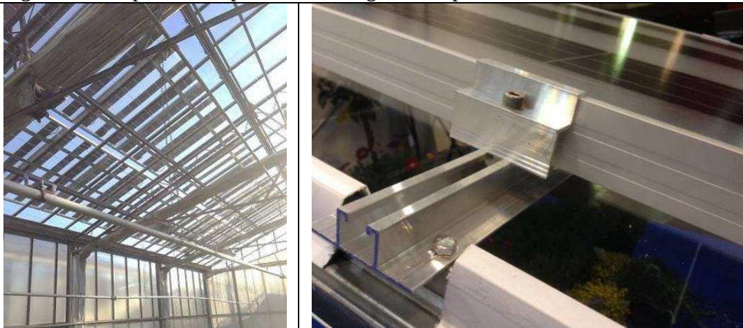
Fig. 78 - Dettaglio di un impianto parzialmente integrato e del sistema di supporto con pannelli in Si (prodotto di progetto)
