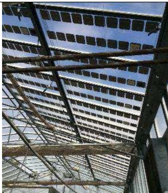
Fig. 12 – Pannelli fissi installati
