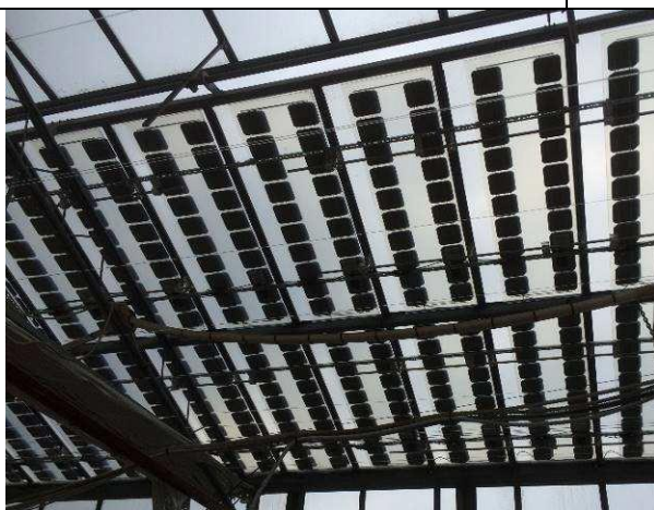
Fig. 46 - Sistema FV mobile con pannelli sovrapposti
