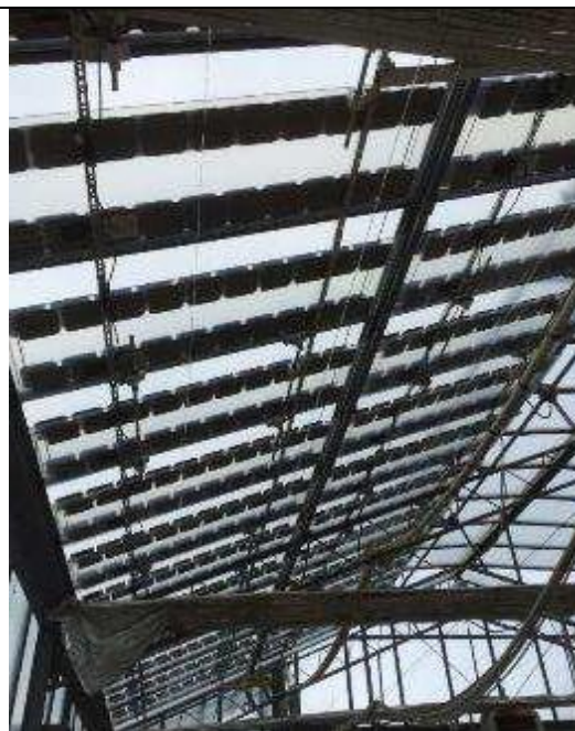
Fig. 13 – Sistema completo di pannelli mobili (modalità aperta)
