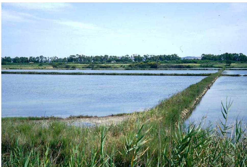
Figura 2. Sterro: veduta di alcune vasche; sulla destra si può vedere un terrapieno crollato.
