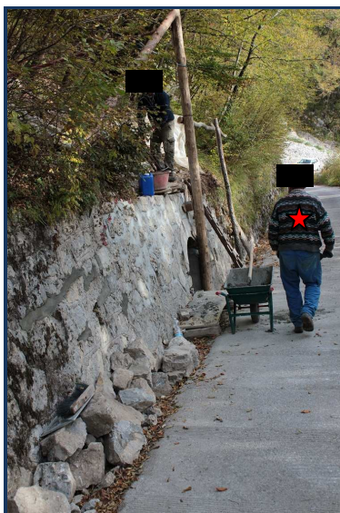
Movimentazione della malta tramite carriola fino alla postazione del secondo operatore.
