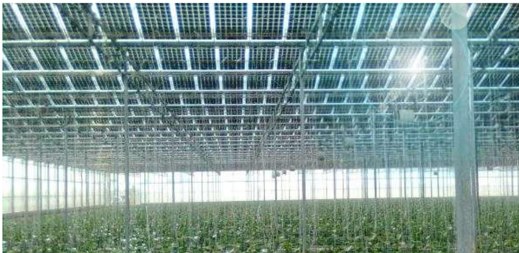
Esempio 4: Serra fotovoltaica agricola con moduli semitrasparenti vetro-vetro
