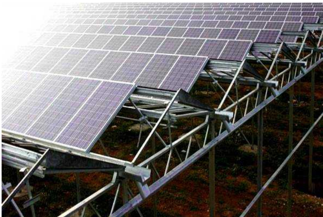
Esempio 3: Serra fotovoltaica industriale con struttura in ferro e pannelli posizionati su più falde
