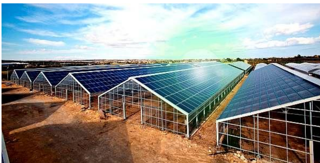
Esempio 2: Serre fotovoltaiche industriali con pannelli esposti su falda unica (sola falda sud)
