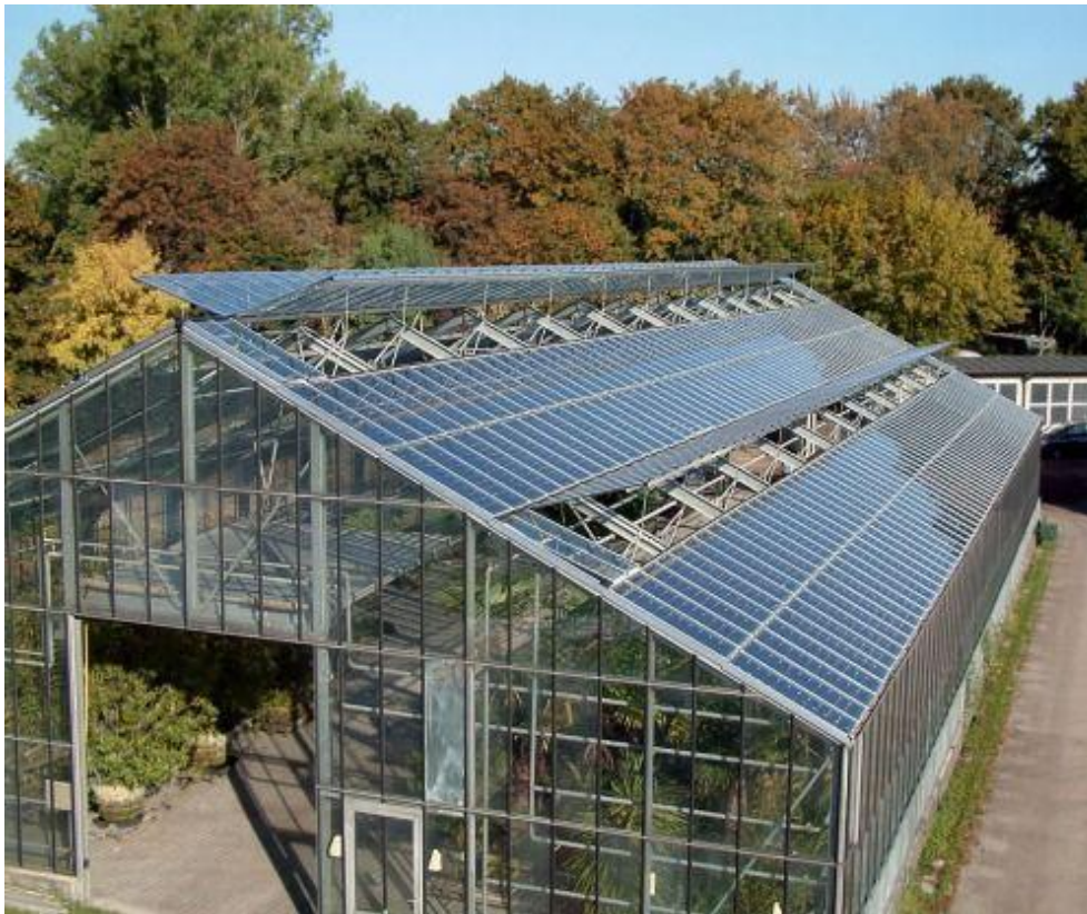
Esempio 1: Serra fotovoltaica ad uso vivaistico con pannelli regolabili in base alle necessità.
