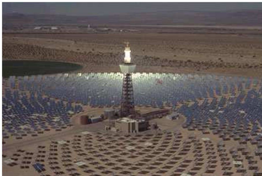
Figura 19. Impianto Solar Two da 10 MW (California)
