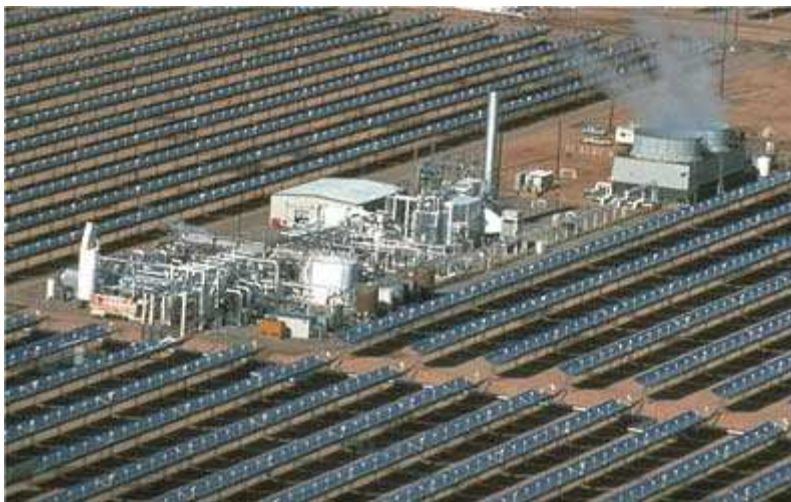
Figura 17. Impianto a collettori parabolici lineari di Kramer Juctio (California)
