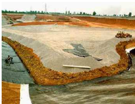
Figura 1. Rivestimento impermeabile del fondo e delle sponde della discarica
