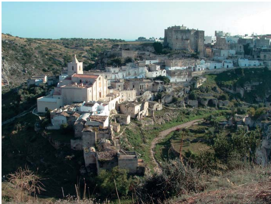
La contrada di San Martino e la Contrada della Porta viste dalla chiesa rupestre di San Vito Vecchio.
