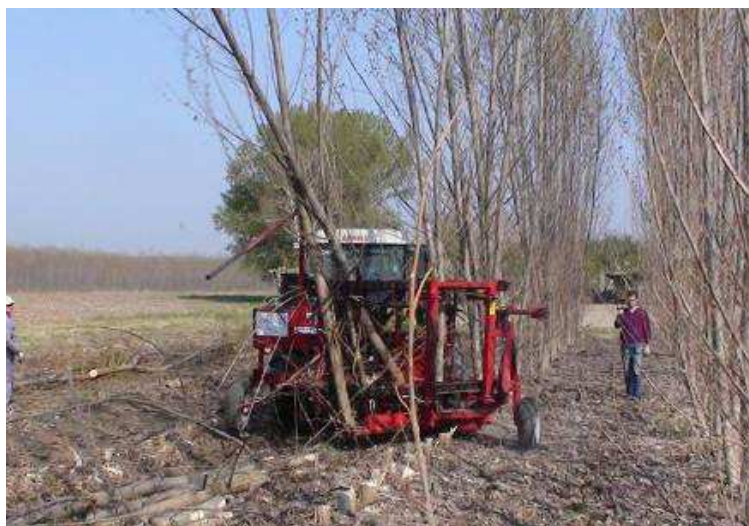
Foto 53 – Prove di abbattimento di pioppo R3F3 (Montagnana - PD).
