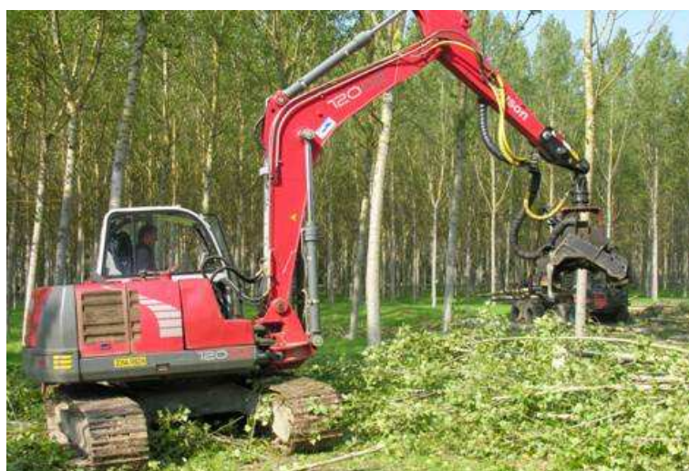
Foto 22 - Testata abbattitrice allestitrice su escavatore cingolato.
