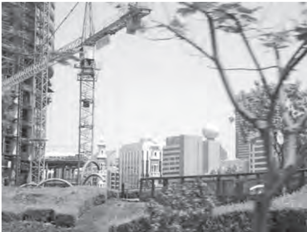
Fig. 2 - Quartieri in costruzione a Abu Dhabi.
