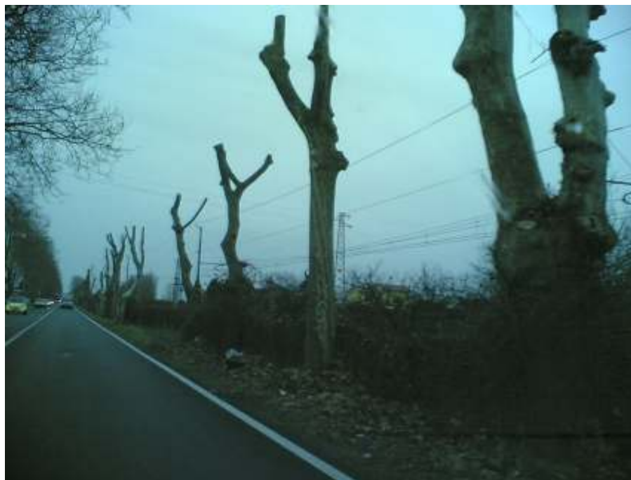
Foto 6 – Esempi di capitozzature eseguite lungo una linea ferroviaria in prossimità di cablaggi elettrici, Nettuno (RM)
