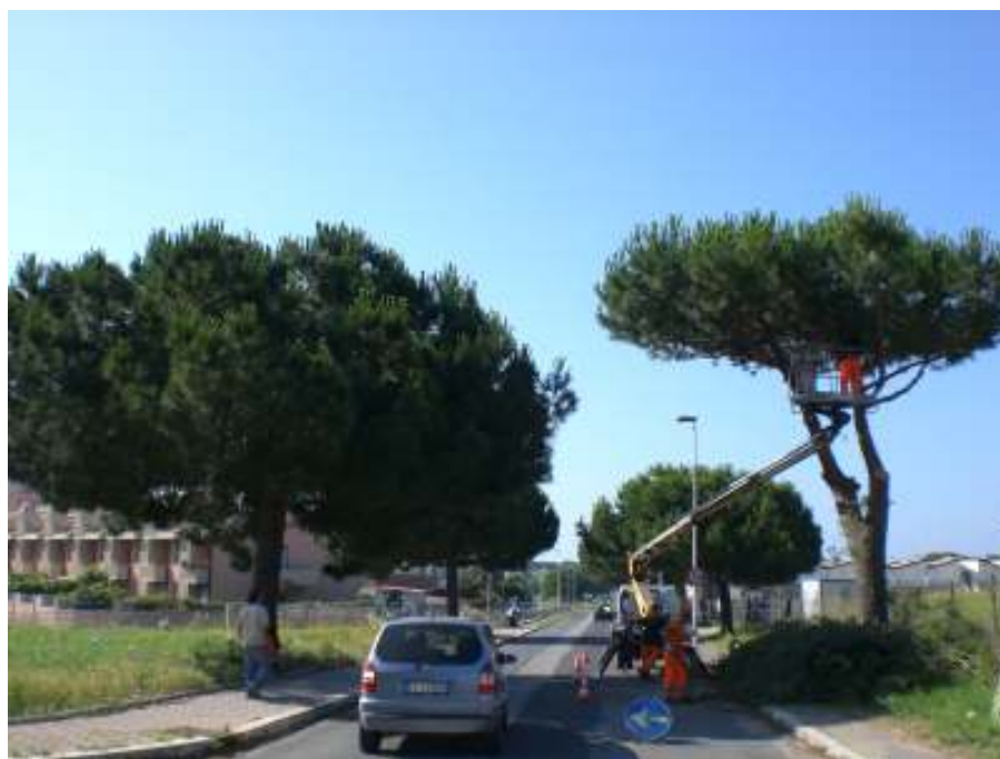
Foto 33 – Piattaforma aerea da 18 m al lavoro su piante con altezza inferiore ai 15m
