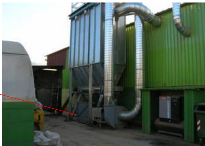
Figura 13: struttura esterna dell' aspiratore
