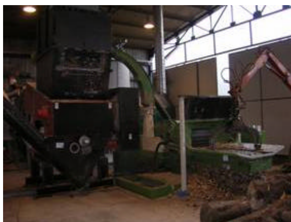
Figura 11: particolare del trituratore che viene alimentato dal condotto di scarico della cippatrice
