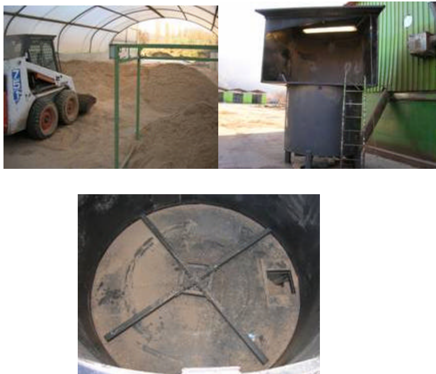
Figura 17: a destra bobcat in fase di caricamento nella serra, a sinistra silos n°1 con apertura superiore, in basso dettaglio dell'agitatore
