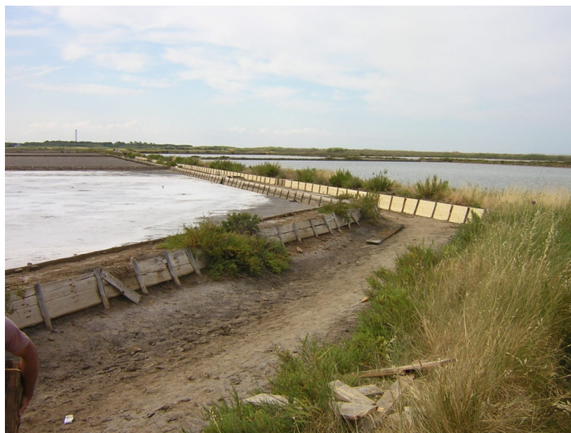
Fig. 5 - Restauro degli argini in legno.
