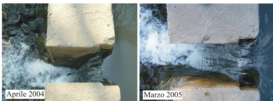
Foro 10.1 – Stramazzo che regola la portata del Marta verso la Centrale Fioritella nell'Aprile del 2004 e nel Marzo del 2005.
