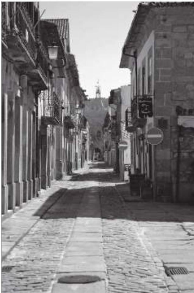
fig. 2 – Caminha, Rua Direita (main street).
