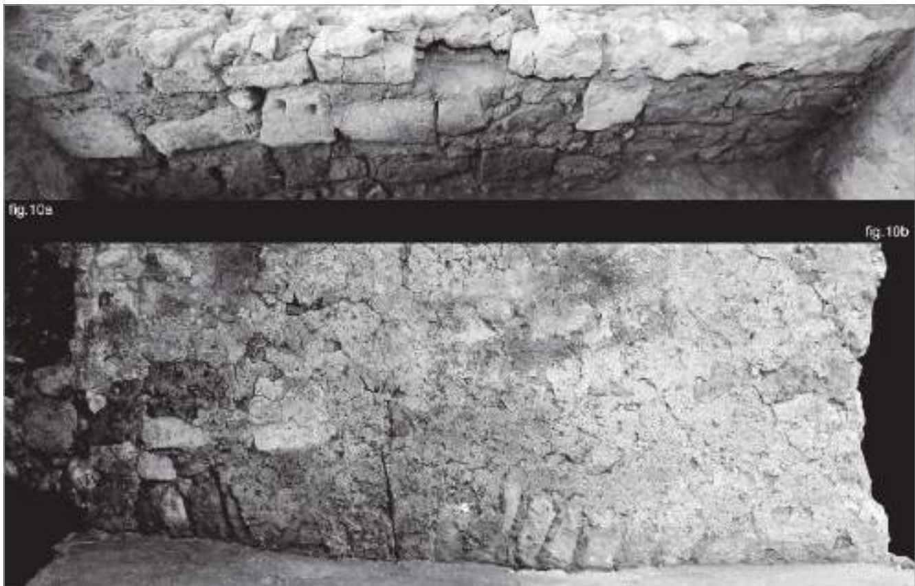
figg. 10a-b – Edificio 'D': particolari delle strutture in fondazione. a: muratura realizzata con blocchi della cinta urbana di IV sec. a.C.; b: arco di scarico tessuto in una delle murature.
