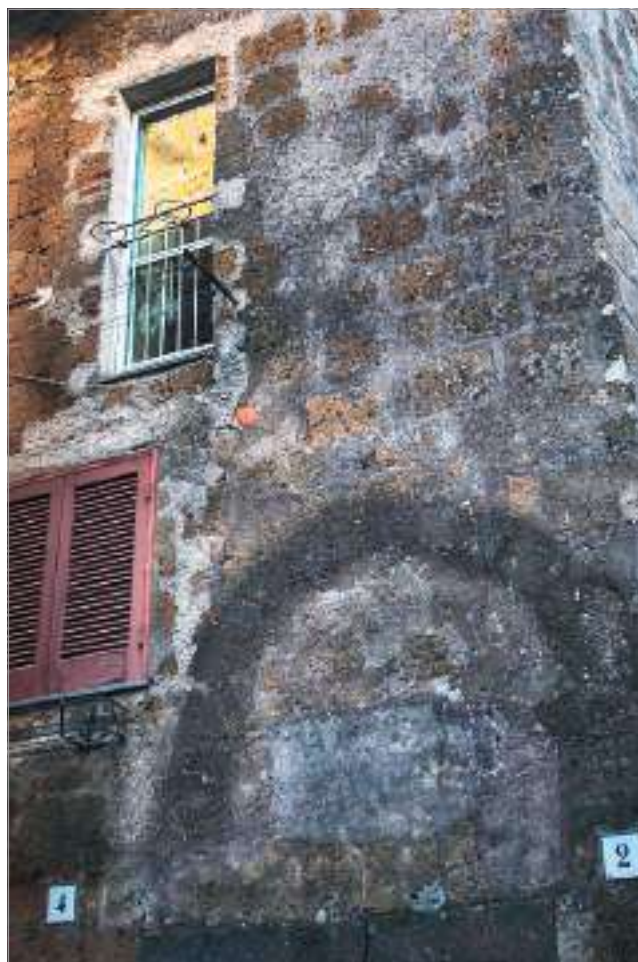
fig. 11 – Vicolo Pisaneschi, particolare della ricucitura nella muratura (foto Vittorio Sperandei).
