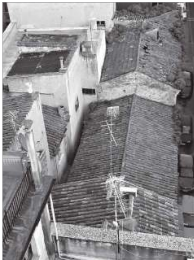
fig. 7 – Veduta dall'alto delle case a schiera di Terranova (Olbia) dal fronte molto largo e profondità ridotta, con vicolo comune di servizio nella mediana dell'isolato.
