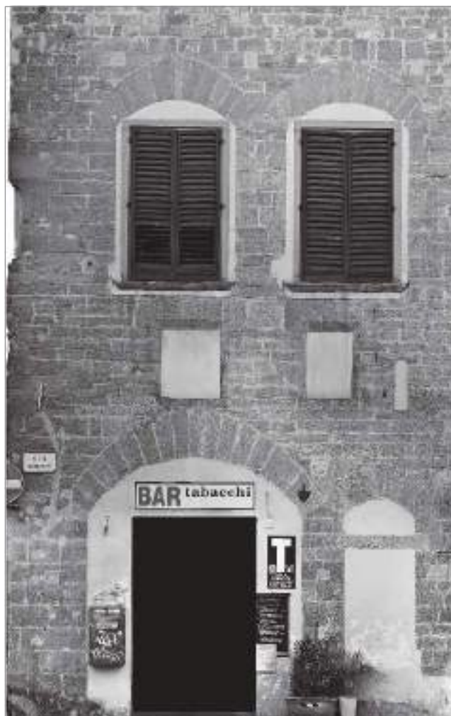
fig. 5 – Fotopiano della facciata di una casa a schiera (dettaglio) con portalino e feritoia delle scale, portale della bottega sormontato dalle due finestre del subpalcho in via Maggio 31r (Università di Firenze, Laboratorio di Archeologia Medievale).
