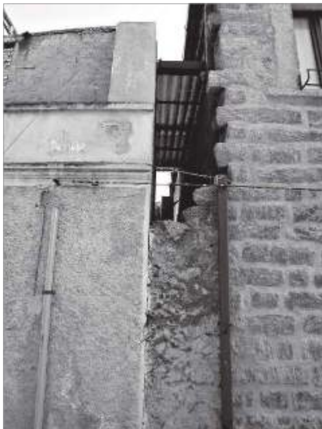
fig. 6 – Uscita del vicolo di servizio sulla mediana dell'isolato, obliterato con muro di terra cruda, a Terranova (Olbia).
