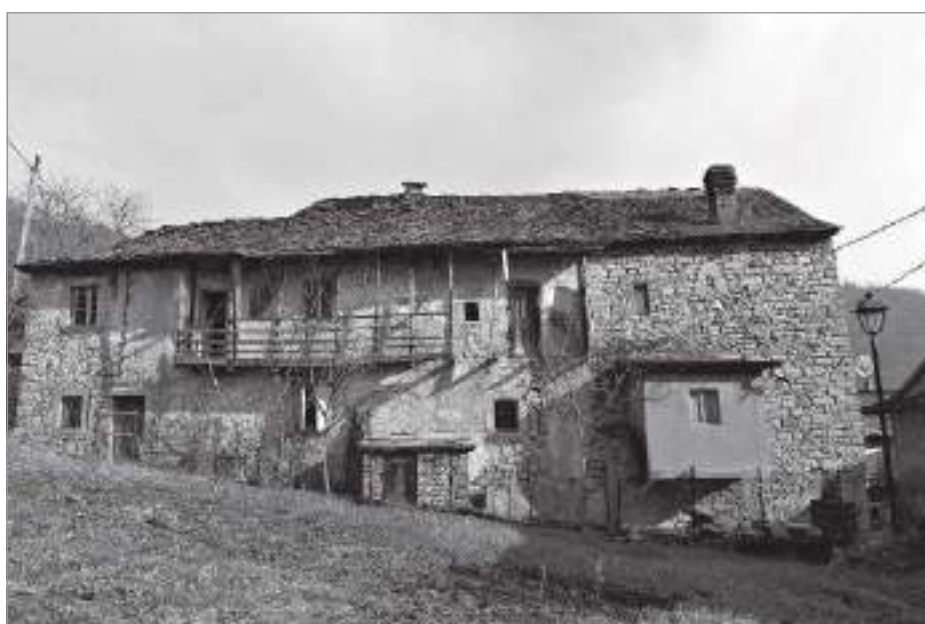
fig. 5 – Edifici in pietra con tetto in piode, Sant’Omobono Terme (BG), frazione Ca’ Taiocco.
