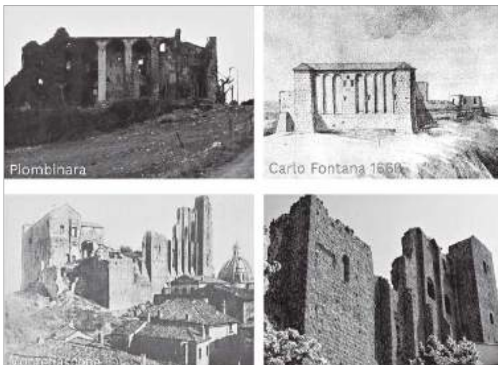
fig. 8 – In alto Castello di Piombinara a sinistra cosa resta della struttura a contraforti a destra lo stesso in un disegno di Carlo Fontana (da SERANGELI 2009). In Basso Montefiascone la rocca in una cartolina storica e dettaglio del sistema a contraforti.
