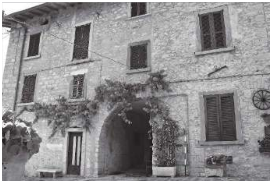
fig. 3 – Edifici con arconi al piano terra, Capizzone (BG), località Cavallina.
