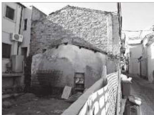
fig. 5 – Sezione visibile per demolizione di una casa a schiera di Terranova (Olbia), con l'originale vicolo di servizio comune intasato da annessi.
