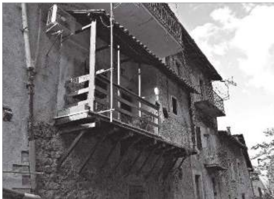
fig. 10 – Tagliacozzo (AQ), gaifo con rifacimenti moderni in via dei Molini (foto dell'A.).
