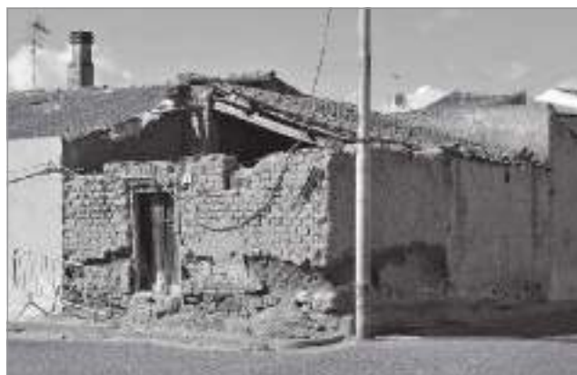
fig. 10 – Casa d'angolo in mattoni di terra cruda, Santa Giusta (Oristano).
