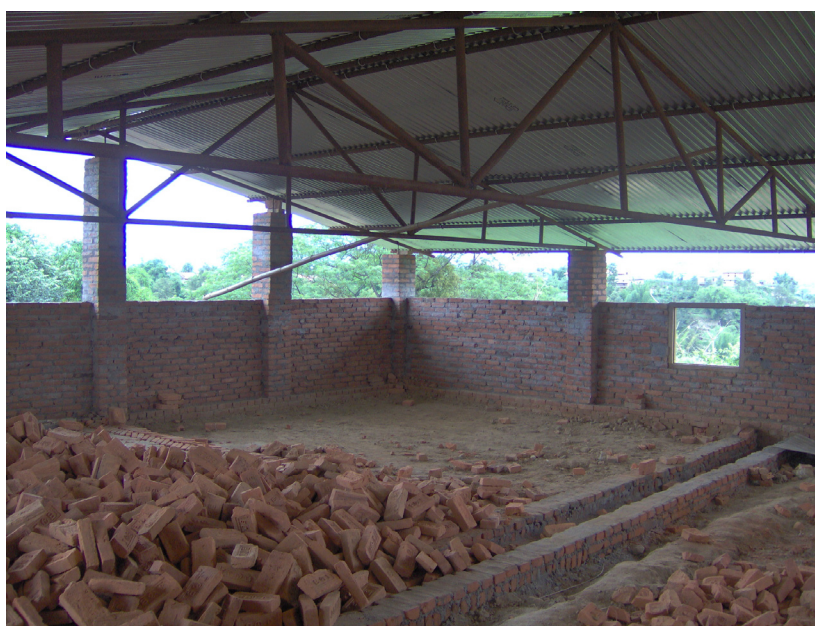
Figura 60 - Interno della stalla ancora in via di costruzione.
