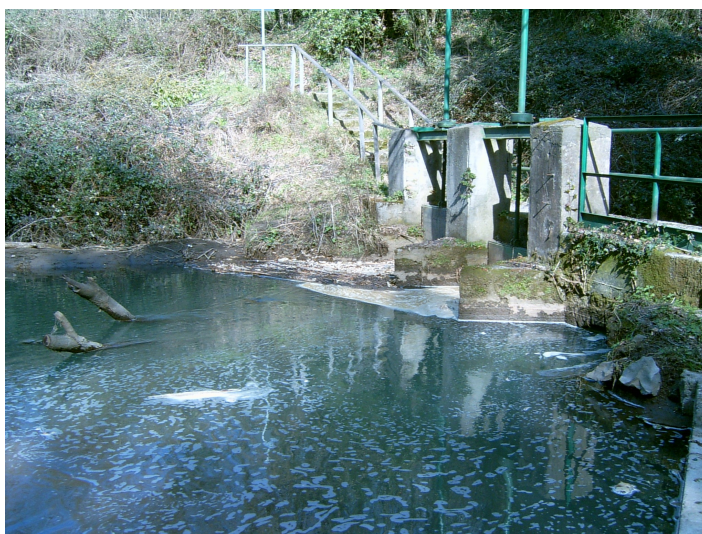
Foto 8.1 – Opera di presa della centrale La Fioritella.
