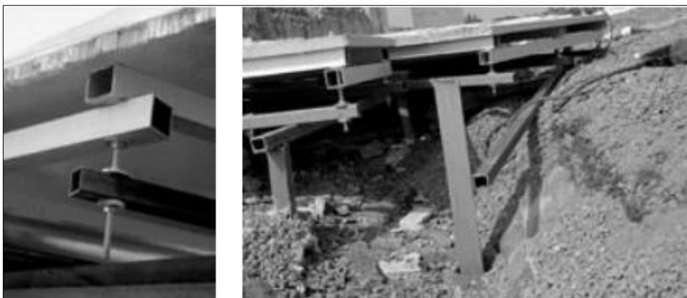
Figura 85 - Sistema con cui è stata riposizionata ed ancorata la pavimentazione sui tre pannelli a nido d'ape (da Lugari 2007).
