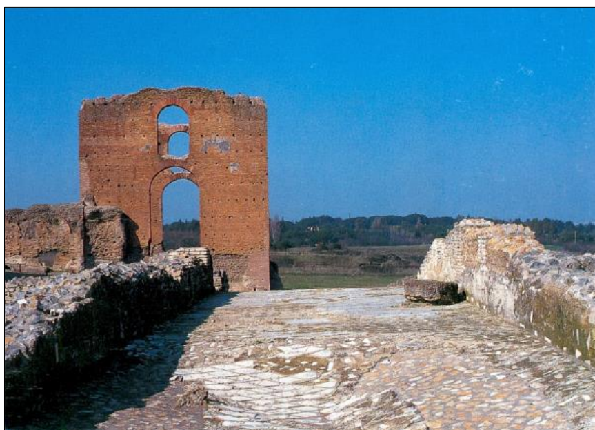
Figura 84 - L'ambiente A8 con in evidenza la porzione di pavimentazione caso di studio in una fase successiva al cedimento delle suspensure (da Paris et al. 2019).
