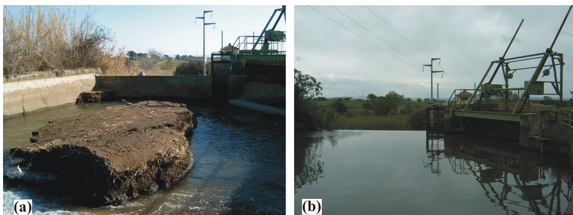
Foro 6.20 – Salto della centrale S. Savino III nel Maggio del 2004 (a) e nel Marzo del 2005 (b).
