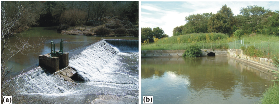
Foro 6.11 – (a) Diga la Roccaccia e (b) restituzione del canale sotterraneo a Centrale Traponzo.
