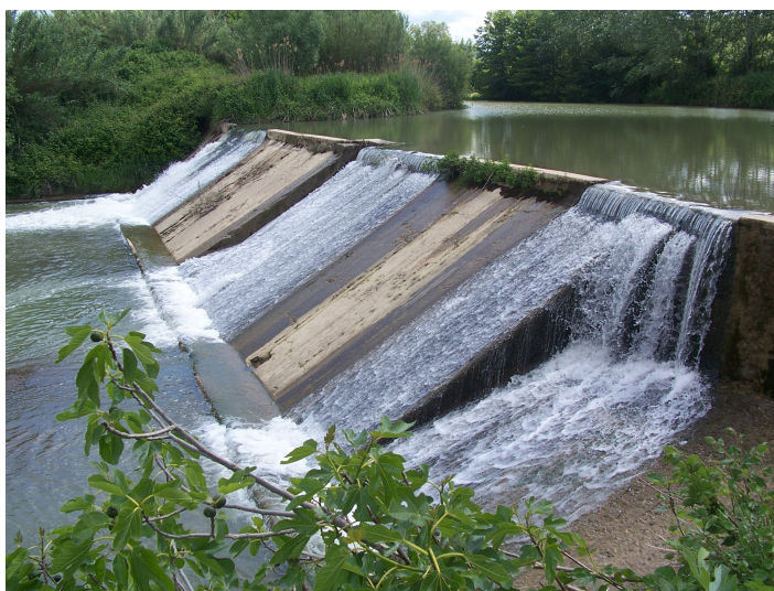
Foro 6.25 – La diga sul Mignone in località “Le Mole”.
