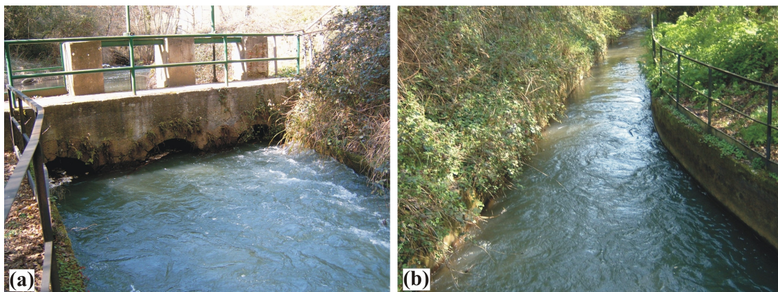
Foro 6.7 – (a) Opera di presa e (b) canale di derivazione della Centrale La Fioritella (stazione I).
