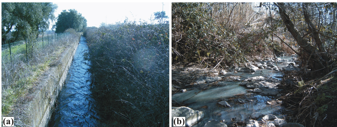
Foto 6.5 – (a) Canale di derivazione della Centrale S. Savino II (Stazione E) e (b) tratto depauperato (stazione E 1 ).
