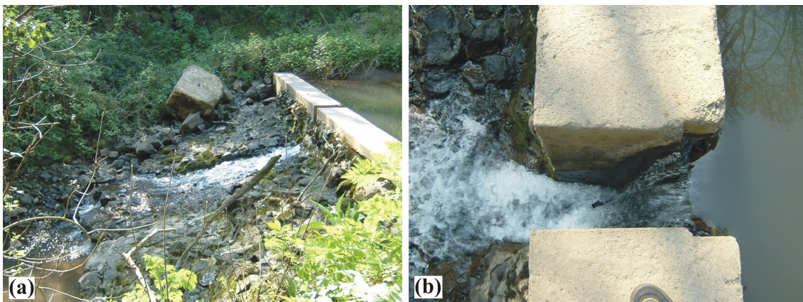
Foto 6.6 – (a) Depauperato della Centrale la Fioritella e (b) particolare dello stramazzo (stazione I 1 ).
