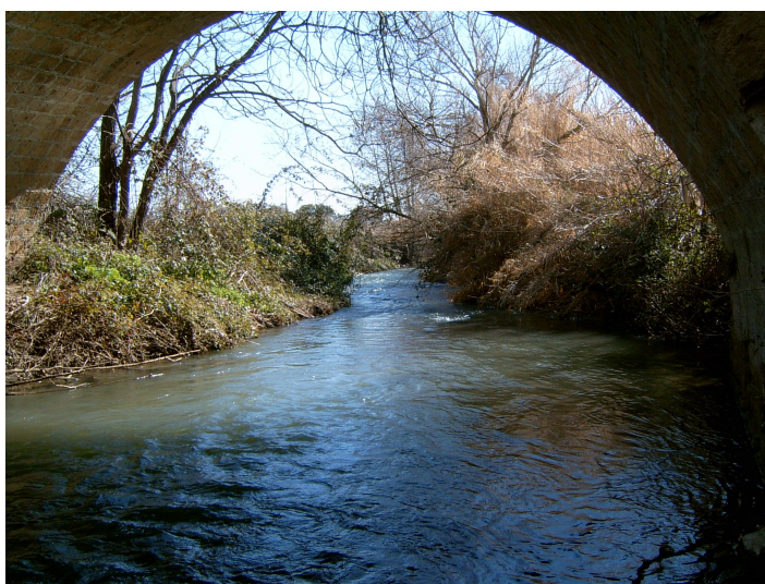
Foro 6.13 – Fiume Marta a valle della Centrale S. Savino III (stazione D).
