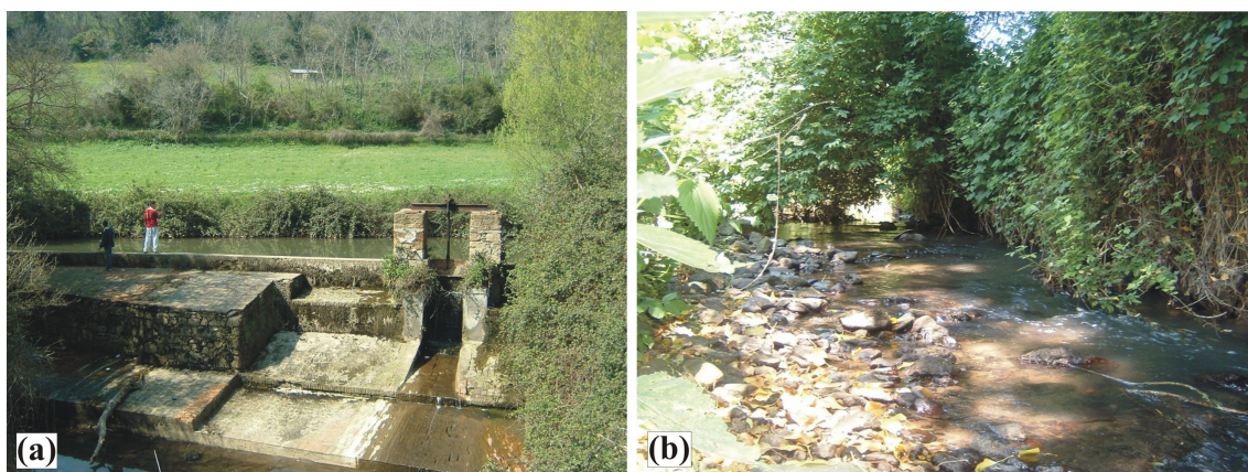
Foro 6.8 – (a) Opera di presa e (b) tratto depauperato relativo all'industria cartaria (stazione M).
