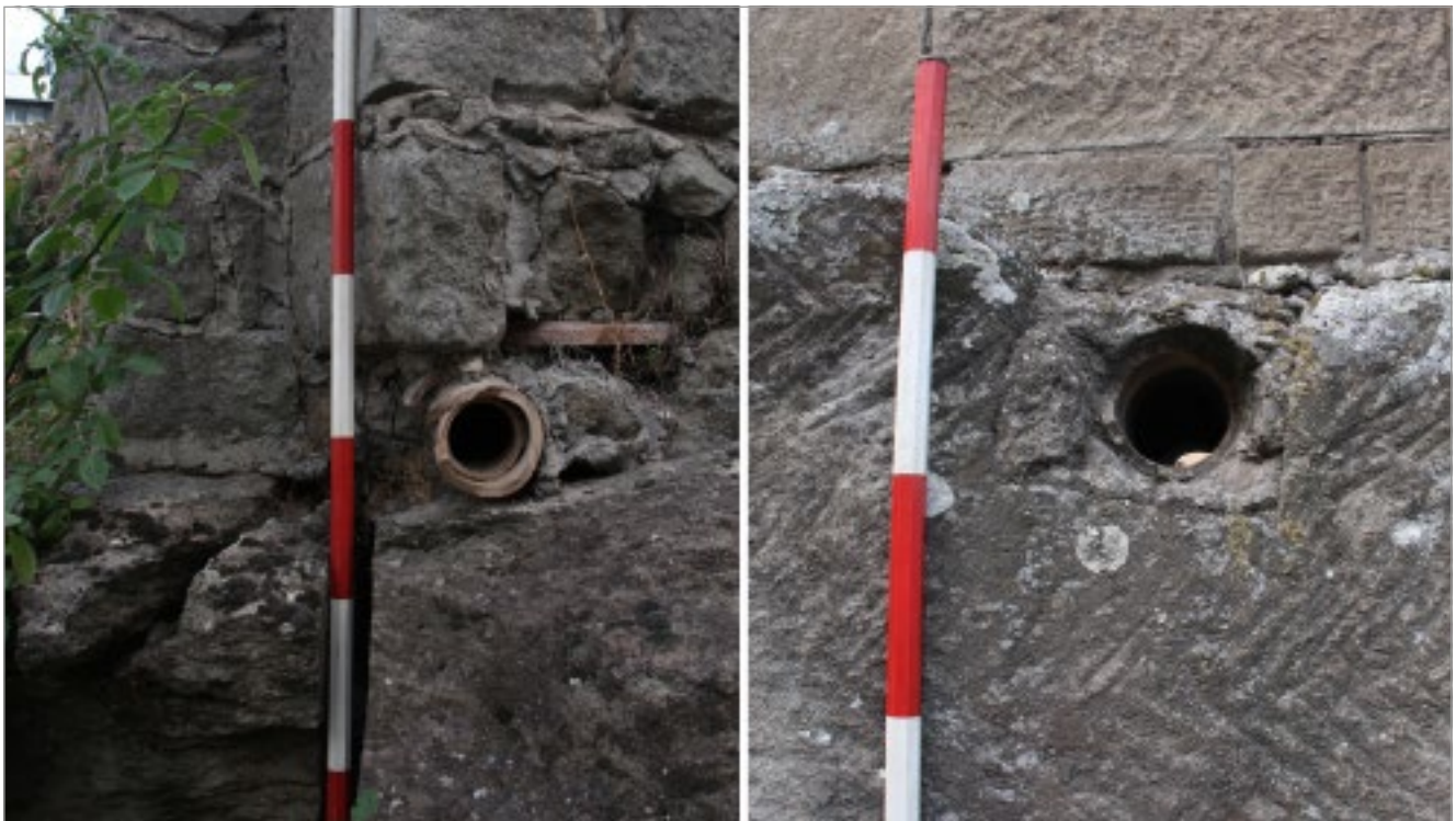
fig. 5 – Tubature dell'acquedotto in loc. Pietrare.
