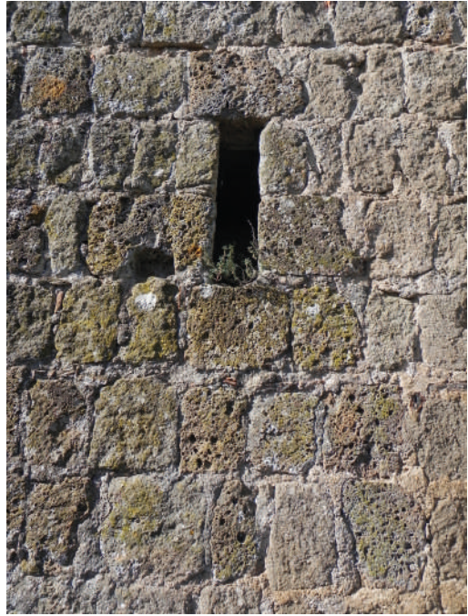
Fig. 10 Muratura medievale in blocchi squadrati di tufo nel Palazzo Altieri
