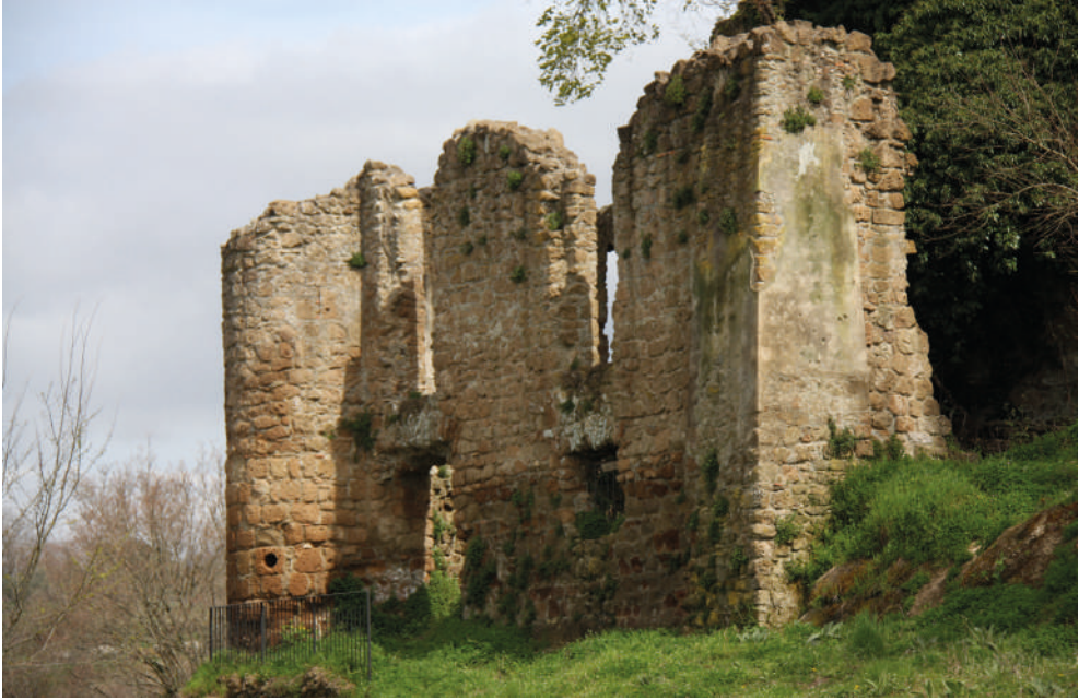
Fig. 20 Torre circolare lungo il lato occidentale della cinta muraria
