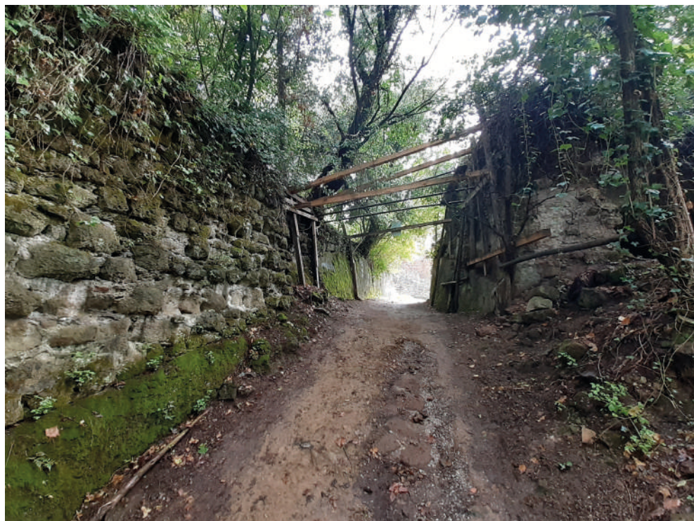
Fig. 18 Tratto di via cava tra la piazza e la porta occidentale
