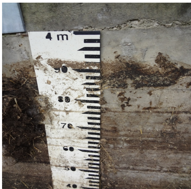
Figura 2-24: Asta metrica per la lettura del livello dei reflui nelle vasche di stoccaggio
