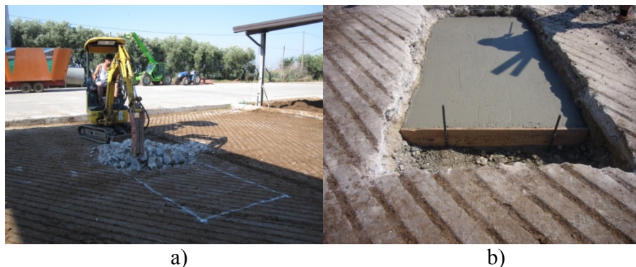
Figura 2-13: Disposizione del sistema di pesatura: a) fase di scavo; b) preparazione del fondo
