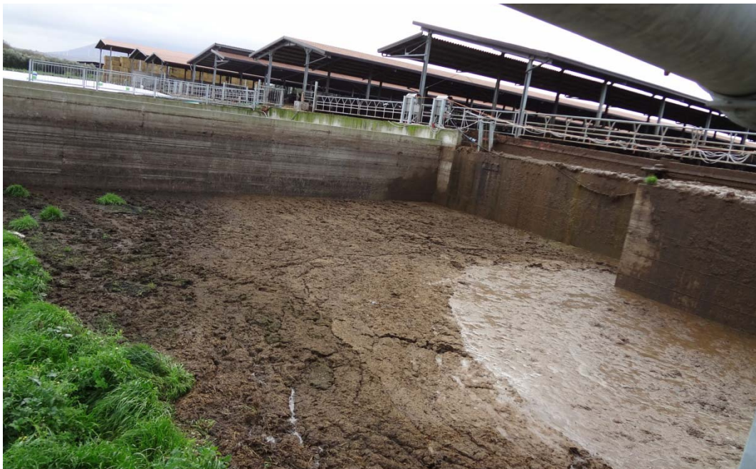
Figura 2-10: Vista di una delle due vasche di stoccaggio dei reflui
