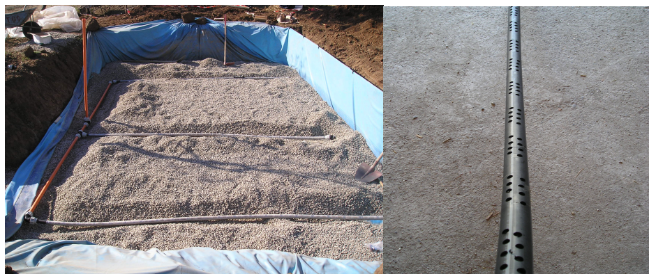
Figura 7.7 Tubazioni per l'acqua nello strato di ghiaia e particolare dei tubi per l'acqua.
