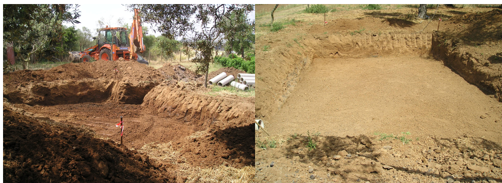
Figura 7.4 Scavo della vasca e livellamento del fondo.
