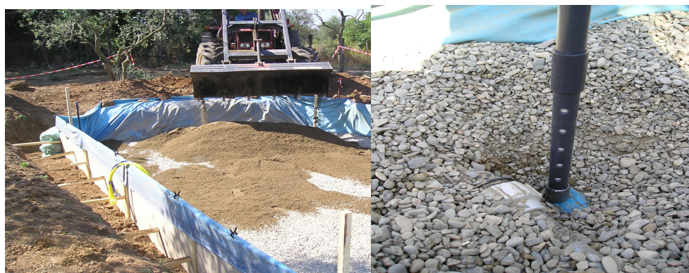
Figura 7.6 Posa in opera del telo impermeabile e particolare del piezometro.
