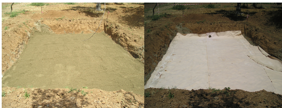
Figura 7.5 Strato di sabbia protettivo alla base della vasca e copertura in feltro.
