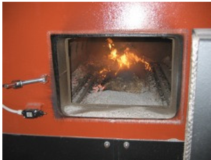
Foto. 1: Caldaia a griglia fissa.
