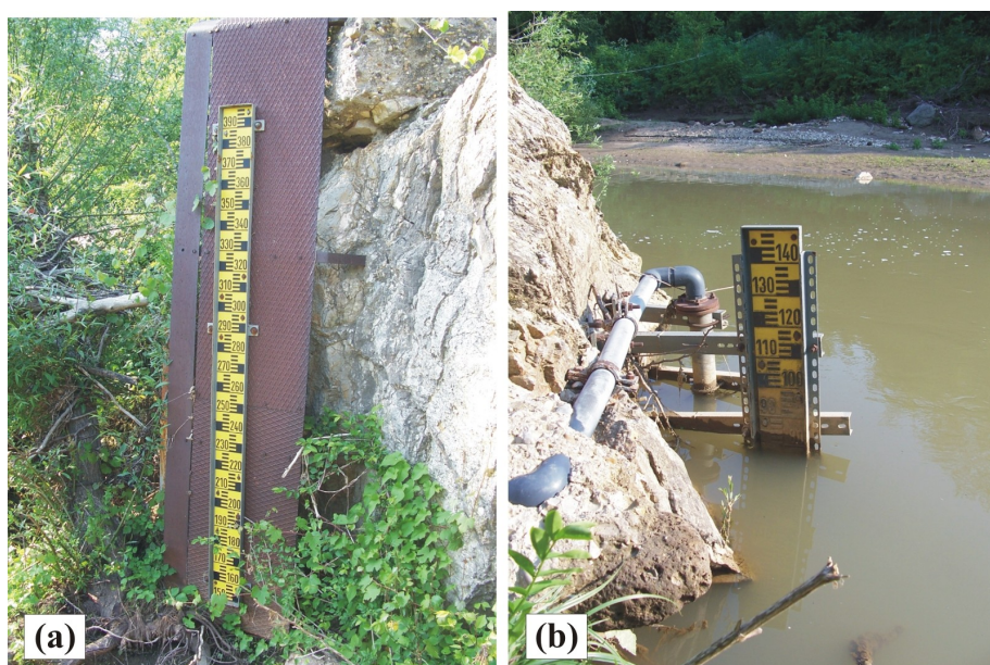
Foro 3.3 – (a) – Stazione idrometrografica di Rota. (b) – Opera di presa dell'acquedotto di Civitavecchia.
