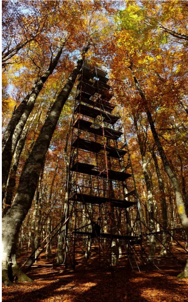
Figura 7: Torre per il monitoraggio dei parametri climatici e dei flussi di carbonio
