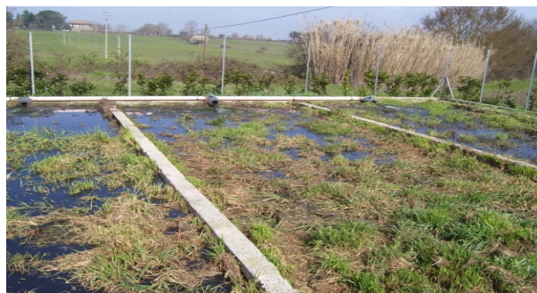
Fig 4.2 A-C: Foto dei tre reattori a cascata dell'impianto di depurazione per il trattamento dei reflui caseari installato presso il Caseificio Sini, Monterosi (VT) (A).
