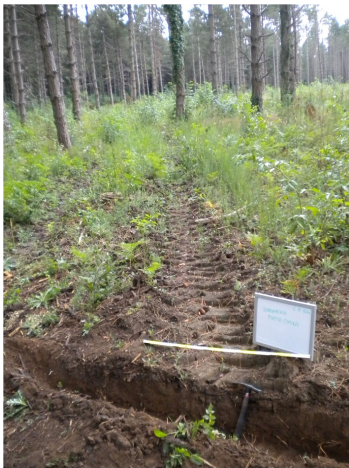
Foto n°20 - Trincea diagnostica “Cantiere strada Cimina”
