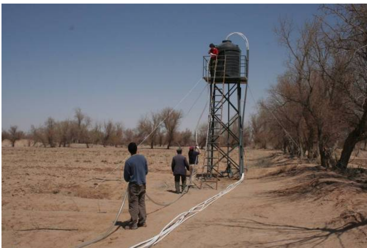
Figura 56 Vista della cisterna piezometrica durante la fase di completamento, marzo 2006.
