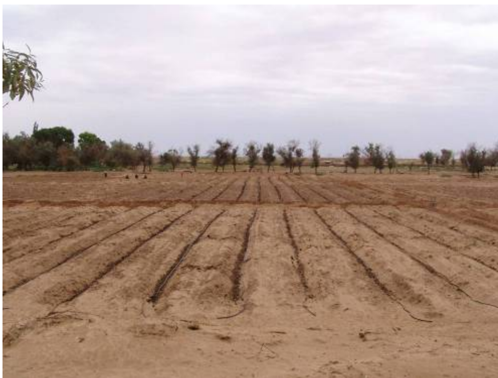
Figura 60 Vista d'insieme dell'impianto d'irrigazione durante le fasi di realizzazione, giugno 2005.
