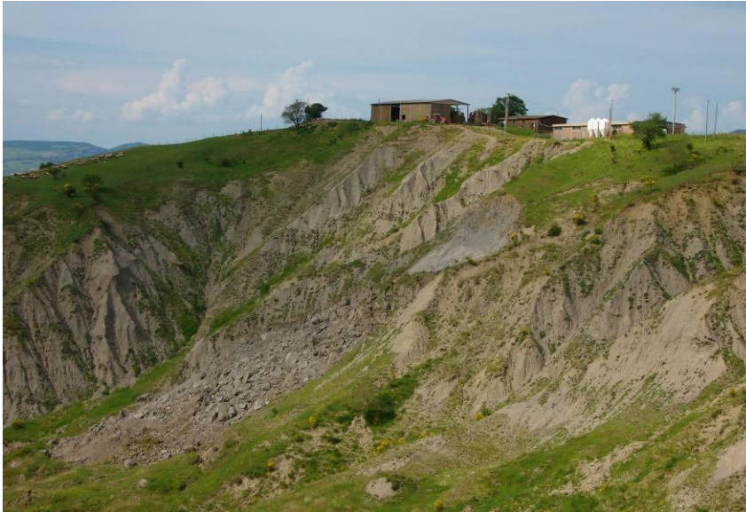
Figura 14: frana di scivolamento traslazionale in area calanchiva (maggio 2010).
