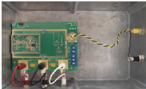
Figura 4-17: Scatola metallica (collegata alla messa a terra) che racchiude l'unità di misura BEB4530-1SI-BUF
