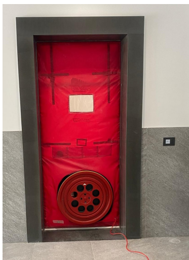
(b) Esterno appartamento - Fase depressurizzazione.
