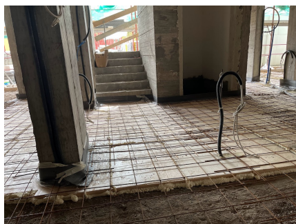
(d) Coibentazione solaio controterra.
