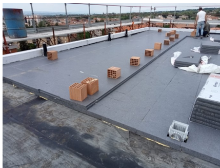
(c) Pannelli EPS spessore totale 14 cm.
