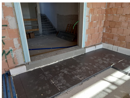
(c) Coibentazione a pavimento balconi.
