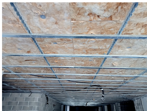
(b) Isolamento in lana di vetro all'interno della struttura in cartongesso di box auto-corsia autorimessa.
