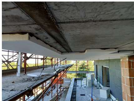
(b) Coibentazione a soffitto balconi.
