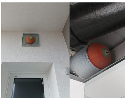
(c) Punti di estrazione ed aspirazione VMC sigillati.
