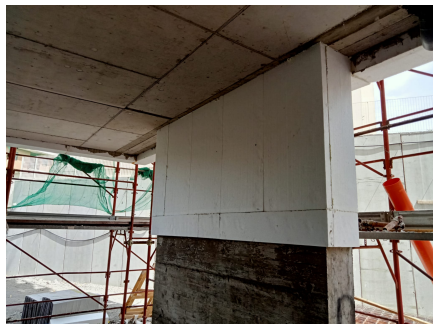
(a) Coibentazione pilastri piano seminterrato.
