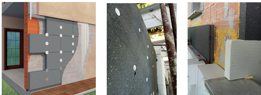
Figura 4.2: Isolamento in polistirene espanso sinterizzato (EPS) grafitato.
