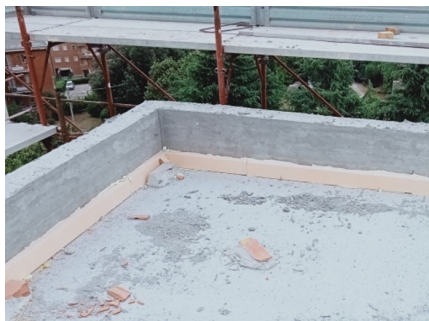
(a) Fase preparatoria per la realizzazione del massetto delle pendenze.
