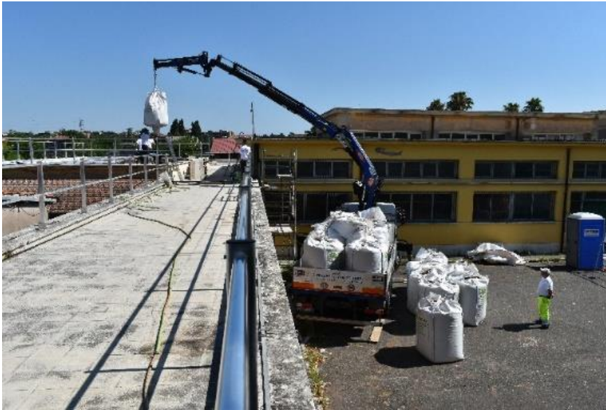
Figura 3.2.2.9 – Arrivo del substrato mediante braccio autosollevante
