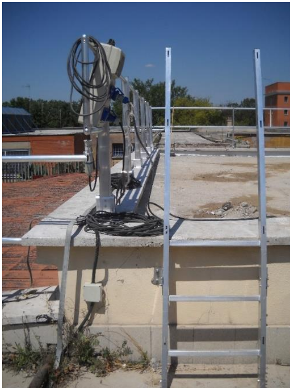
Figura 3.2.2.5 – La scala di accesso al terrazzo
