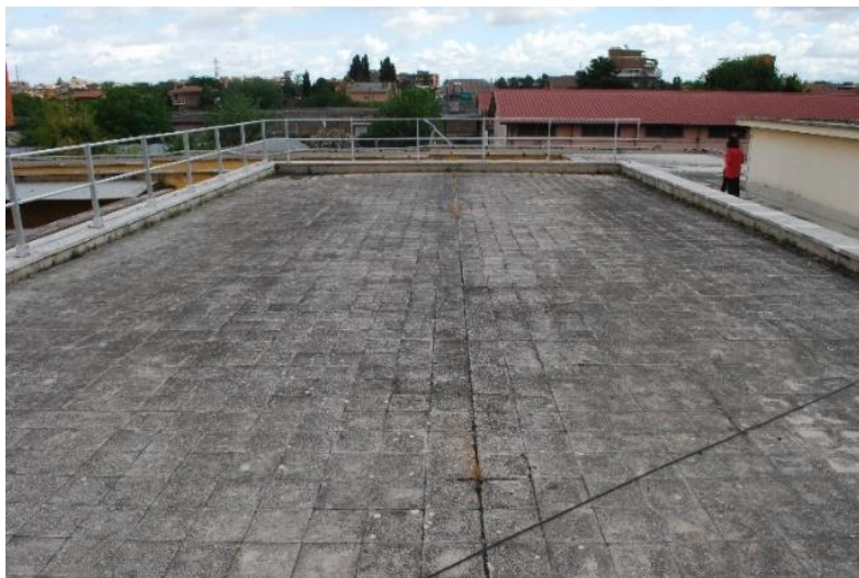
Figura 3.2.2.1 – La copertura ante operam
