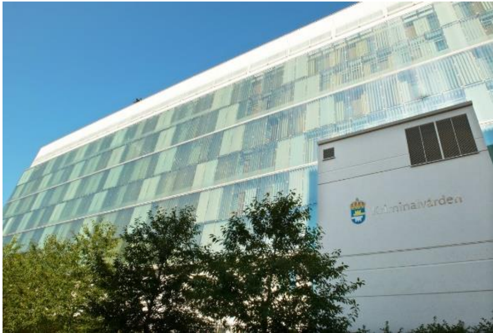
Figura 1.3.5 – La facciata: dettaglio della finitura in vetro isolante (fonte: BRE Group)
