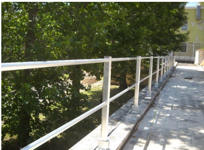
Figura 3.2.2.3 – Dettaglio del parapetto lungo il corridoio di accesso
