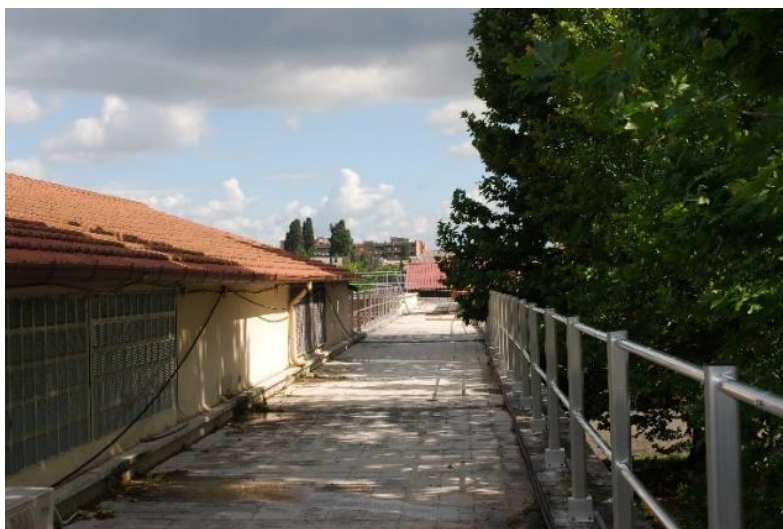
Figura 3.2.2.2 – Il corridoio di accesso dopo l'installazione del parapetto
