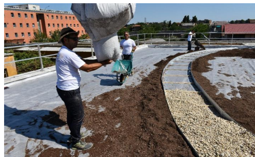
Figura 3.2.2.11 – Fasi della distribuzione del substrato
