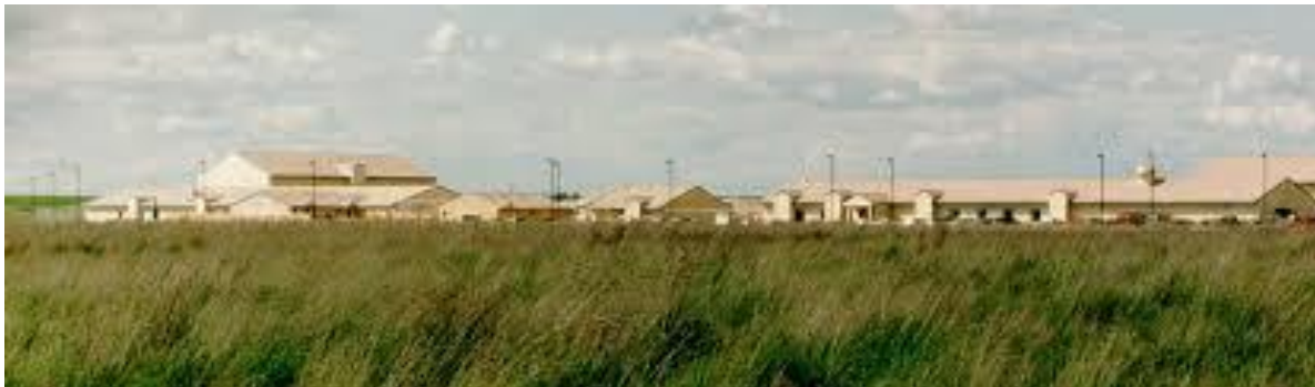
Figura 1.3.8 – Vista dei campi che circondano l’Istituto (fonte: WashingtonCI)
