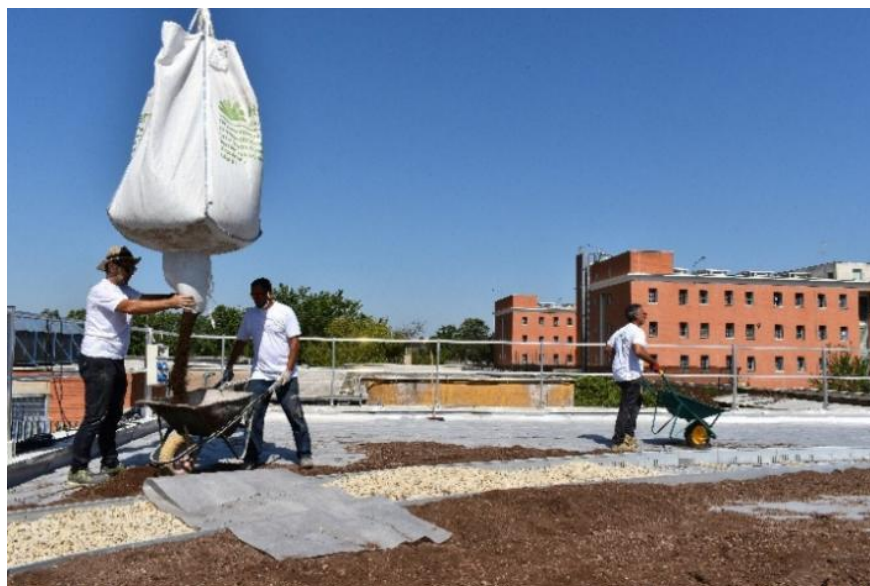
Figura 3.2.2.10 – Apertura dei sacchi di substrato
