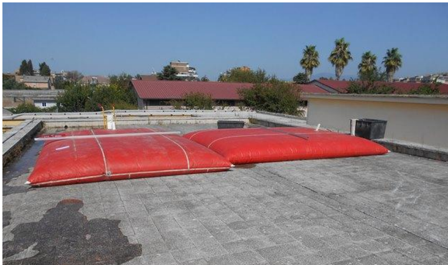
Figura 3.1.4.2– Esecuzione delle prove di carico sul terrazzo tramite serbatoi
