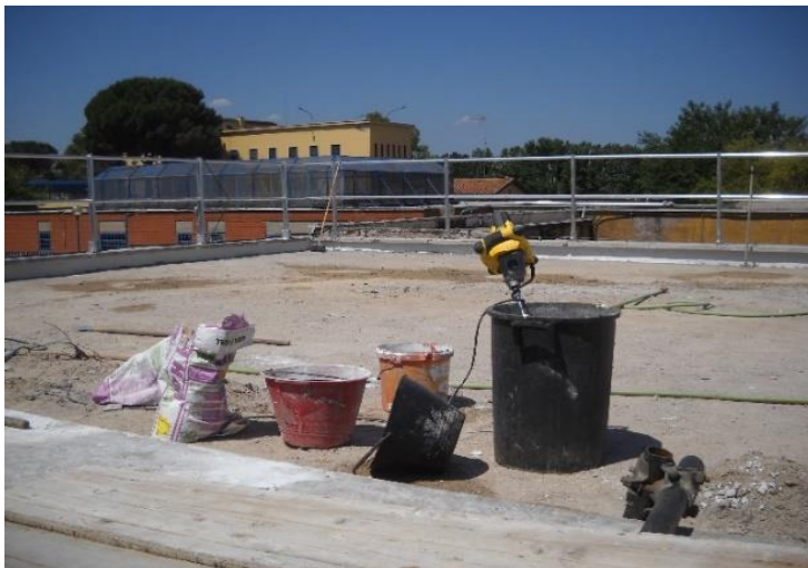
Figura 3.2.2.7 – Demolizione e ripresa del sottofondo
