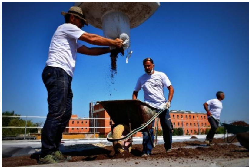
Figura 3.2.2.12 – Dettagli della distribuzione del substrato
