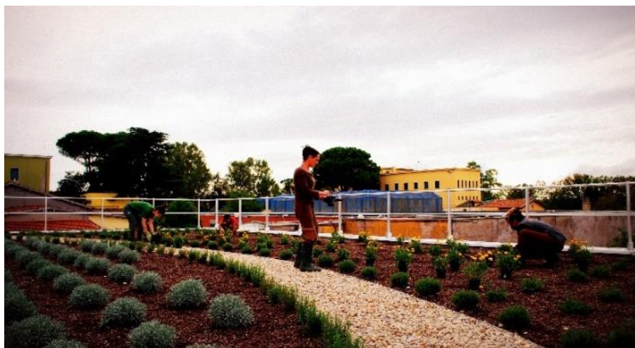
Figura 3.3.2.4– Completamento messa a dimora delle piante
