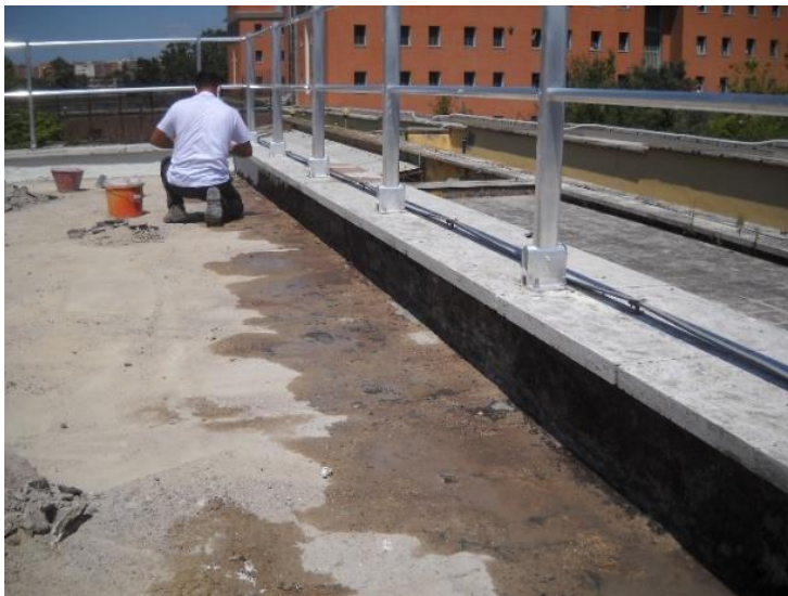
Figura 3.2.2.6 – Demolizione dell'intonaco del parapetto
