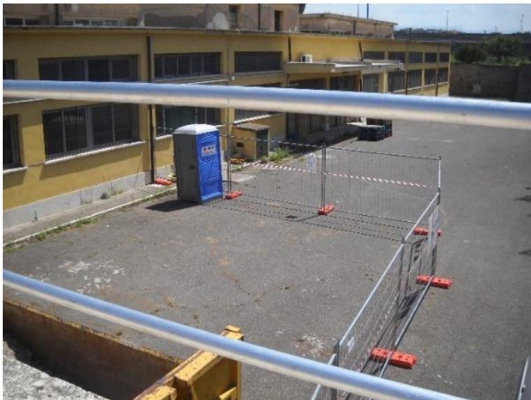
Figura 3.2.2.4– Area deposito materiali
