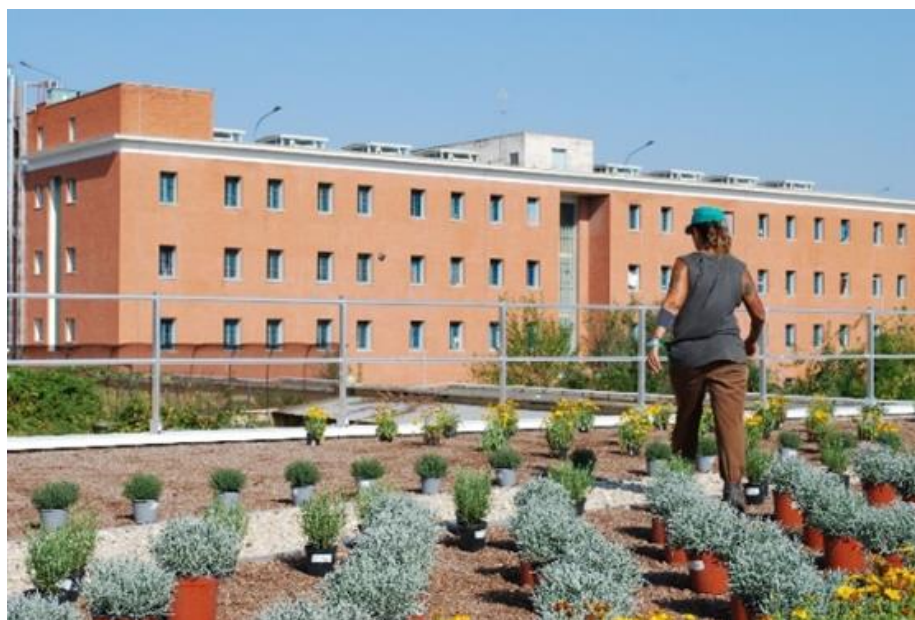
Figura 3.2.2.13 – Fase di distribuzione delle piante sulla copertura
