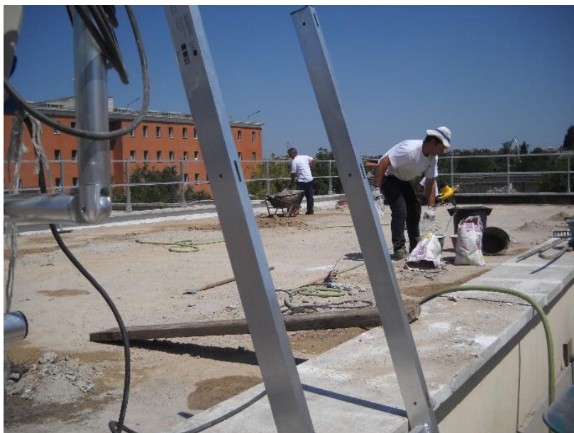
Figura 3.2.2.8 – Creazione di un nuovo massetto delle pendenze
