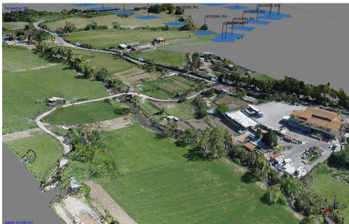
Figura 2.14 illustrazioni della dense cloud, visibile la ricostruzione della porzione urbanizzata
