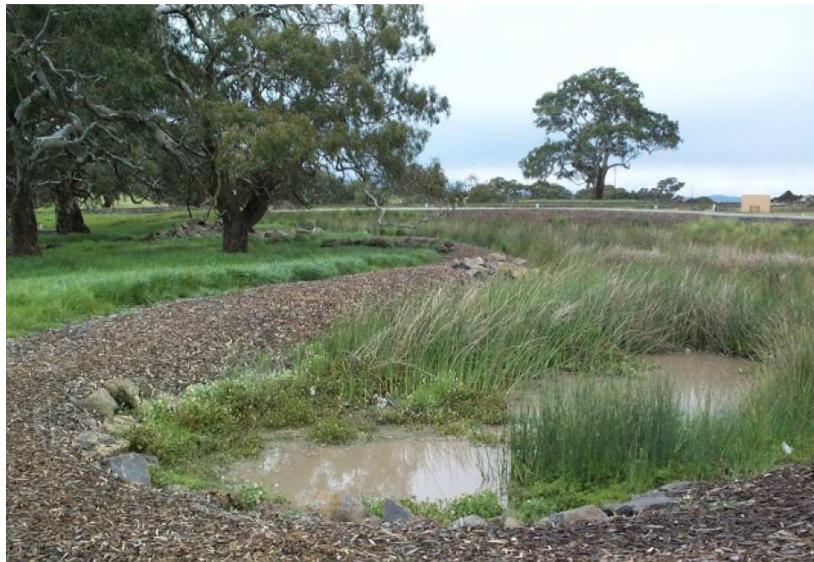
Figura 39 | Bacino per i sedimenti - sediment basins (Tasmania, 2012)
