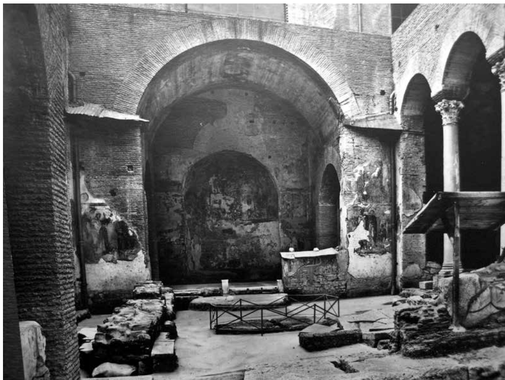
28. Navata centrale con le pitture sui pilastri prima dello stacco
