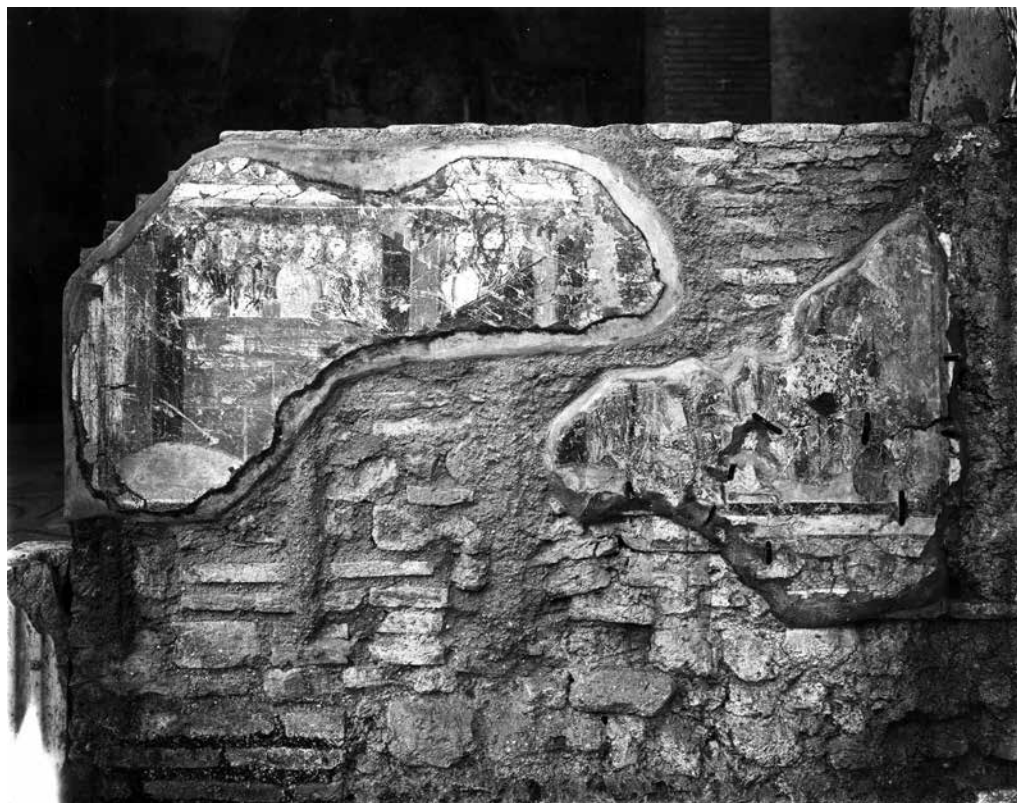
18. Setto murario nella navata centrale con Giuditta e Oloferne dopo lo stacco e la ricollocazione in situ su rete metallica eseguiti nel 1901
