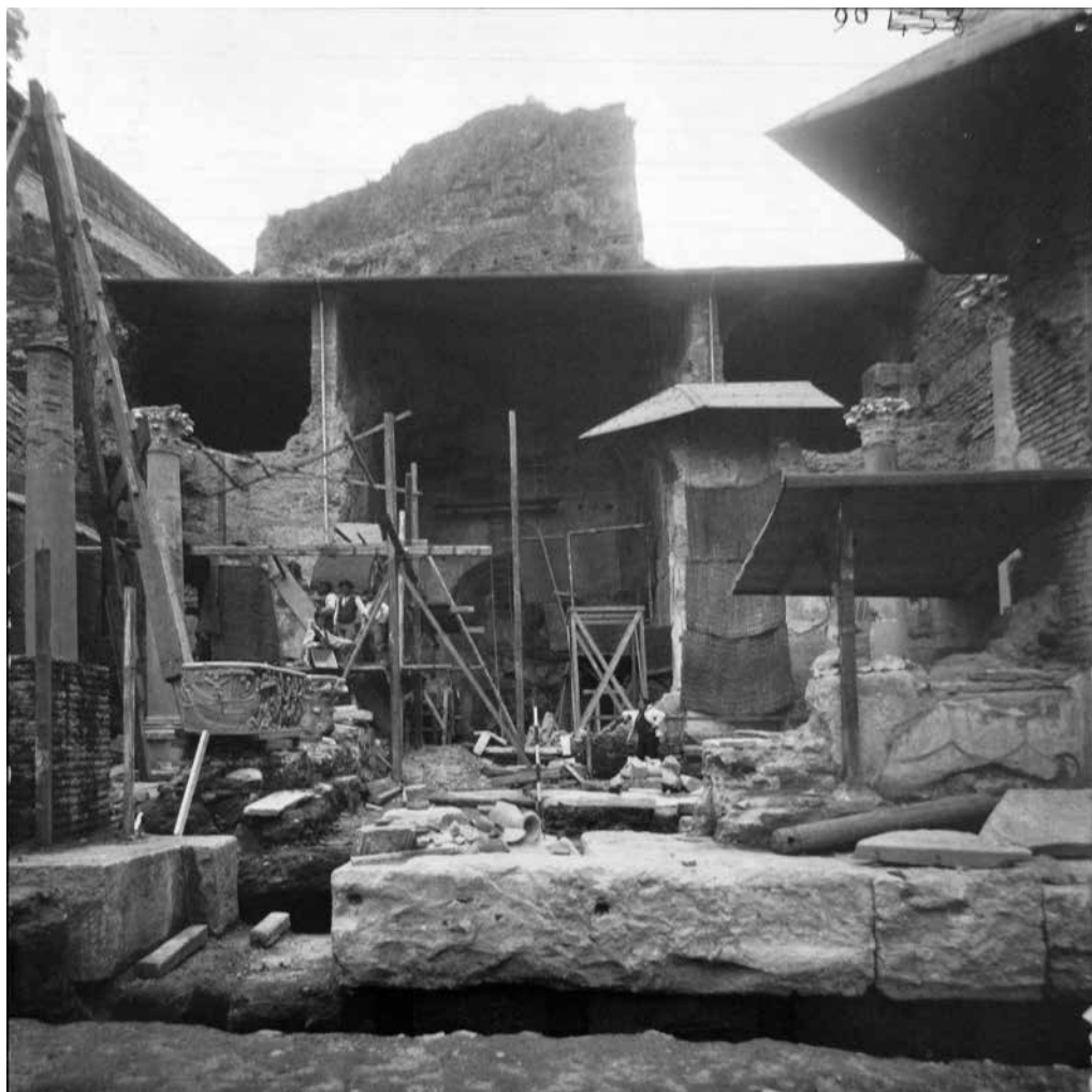
15. Navata centrale e presbiterio durante lo scavo. Si distinguono i sistemi di copertura provvisoria e le stuoie a protezione dei dipinti
