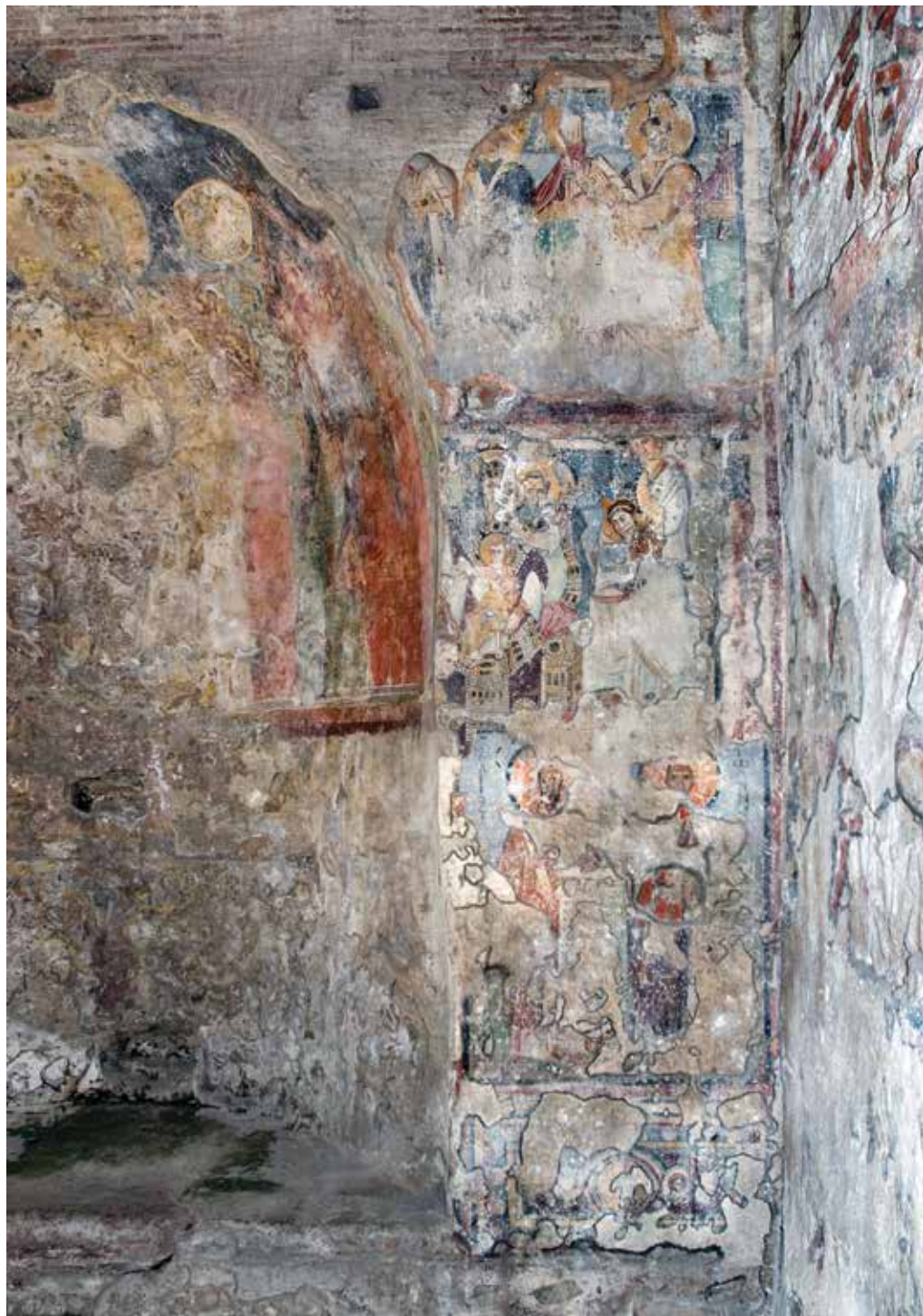
IV. Parete absidale destra, la "Parete palinsesto" (2010)
