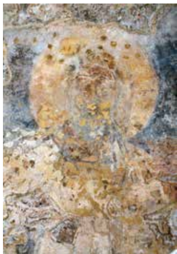
XVII. Calotta absidale, particolare del volto di Cristo prima dell'ultimo restauro. Si riconoscono le grappe metalliche e le stuccature in cemento dipinte in ocra durante il restauro degli anni Settanta
