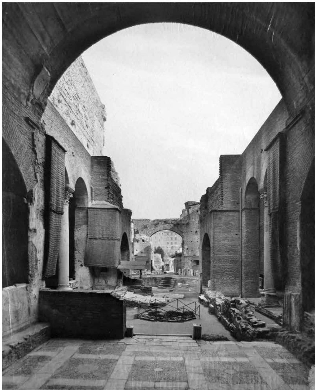
21. Navata centrale dopo lo scavo con le stuoie utilizzate per riparare i dipinti
