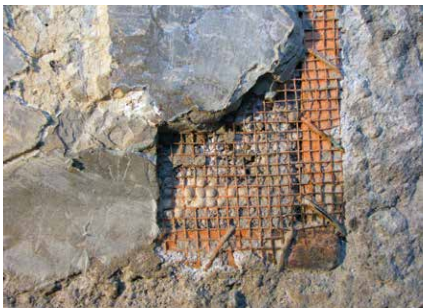
XV. Dettaglio del supporto con rete metallica
