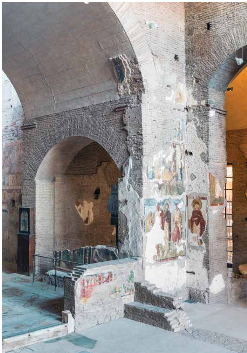
XXXVIII. Pilastro sud-ovest della navata centrale dopo l'ultimo restauro
