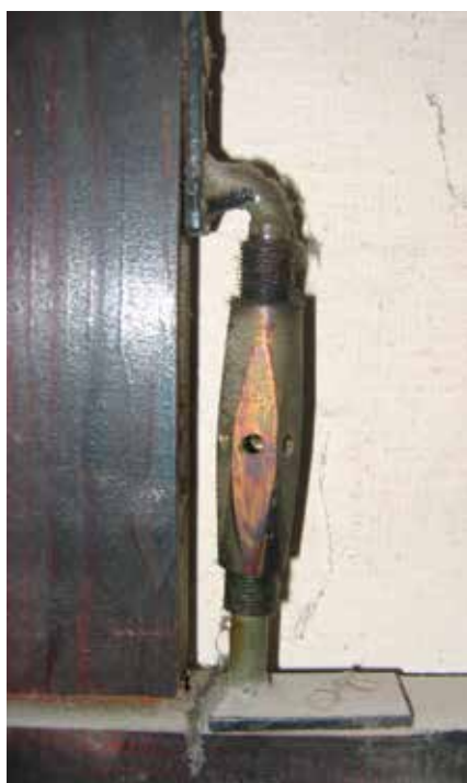
XXIX-XXXI. Particolare del supporto in tela su telaio ligneo e del sistema di tiranti
