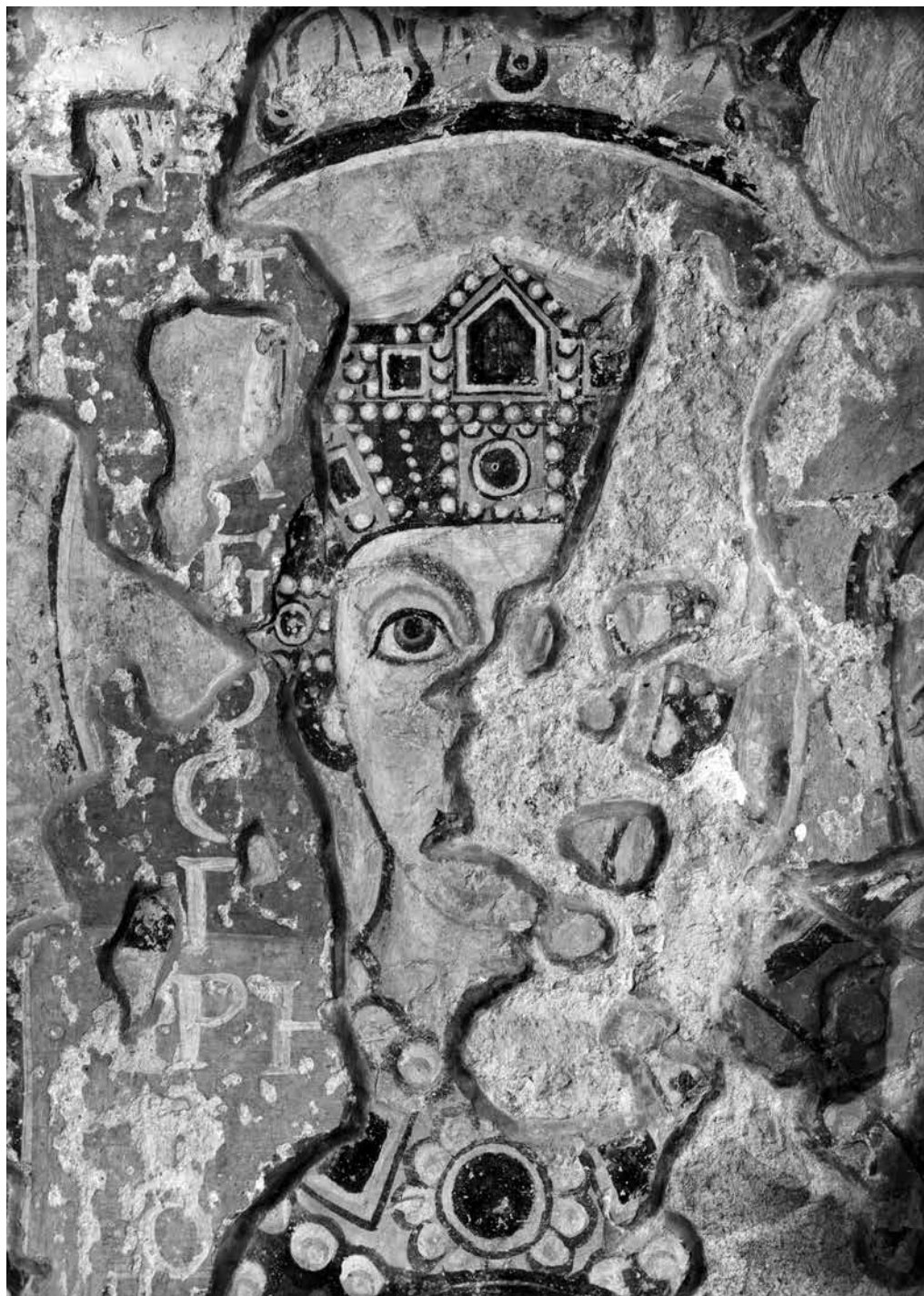
12. Particolare del volto di Maria Regina in cui si leggono le stuccature in cemento che chiudono tutti i frammenti di intonaco dipinto presenti sulla parete
