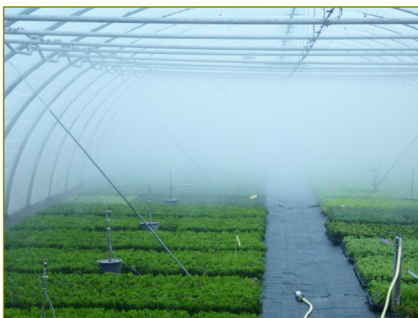
Figura 14. Il fog-system genera una sorta di nebbia artificiale che permette di mantenere elevati livelli di umidità relativa nella serra di propagazione.
