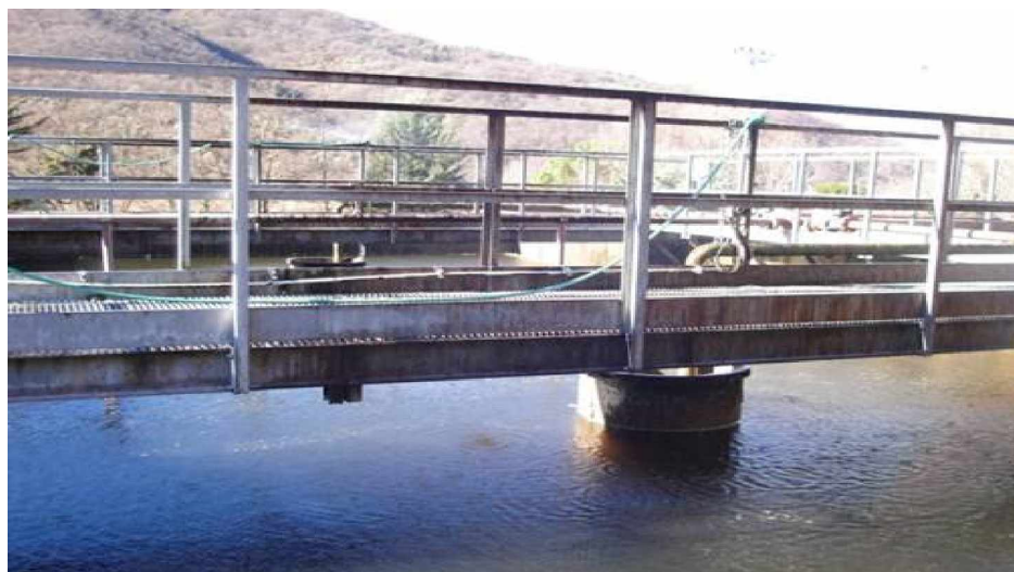
Fig. 4 Particolare dell'impianto di depurazione
