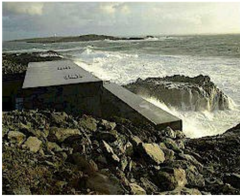
Figura 5-1. A sinistra installazione sperimentale del primo dispositivo Limpet. A destra il suo schema di funzionamento
